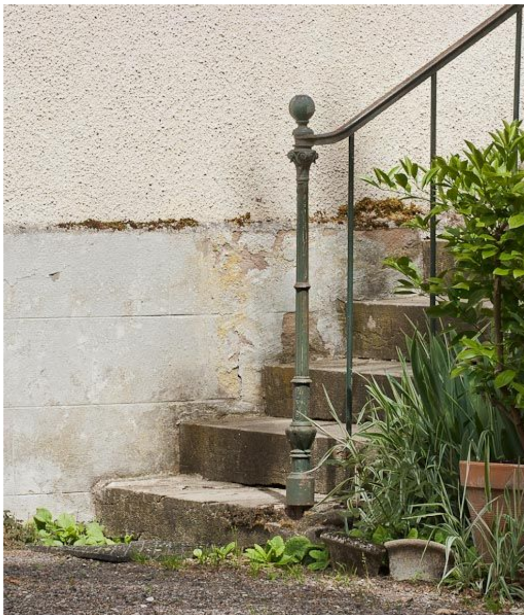
Détail d'un départ de rampe.
