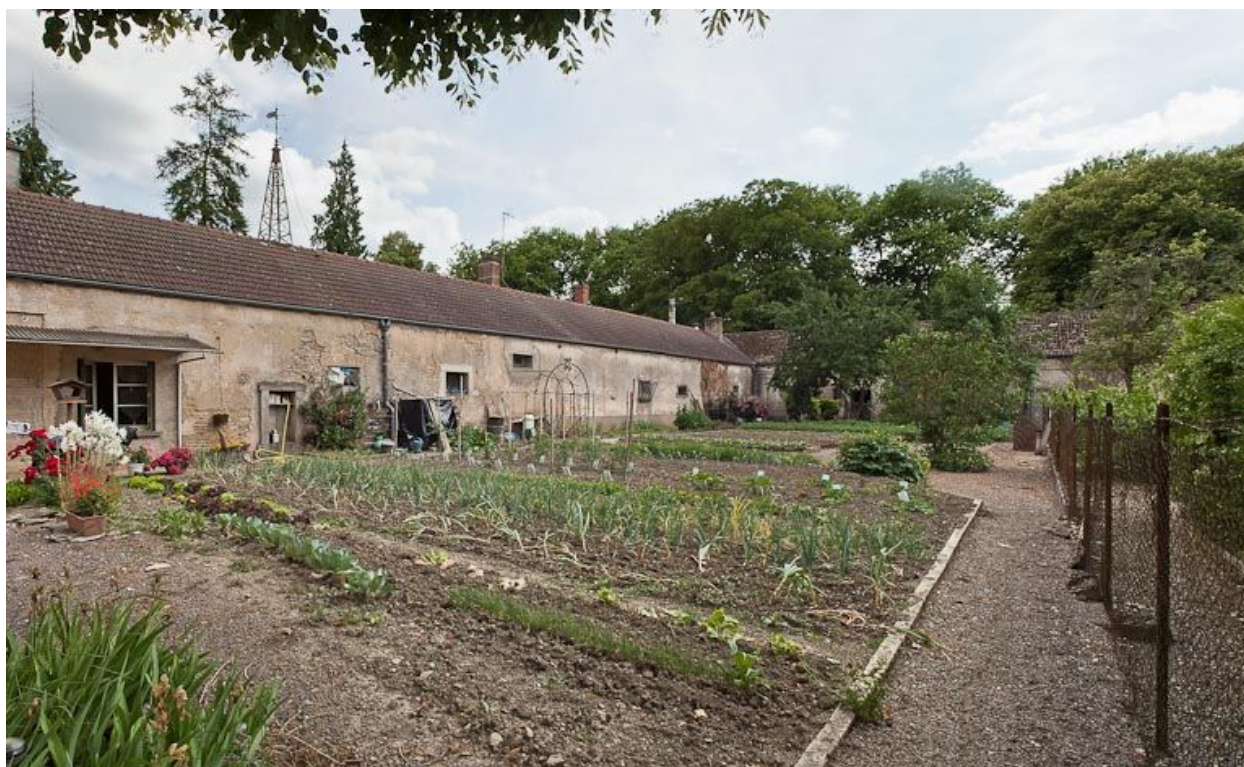
Vue de la cour intérieure.
