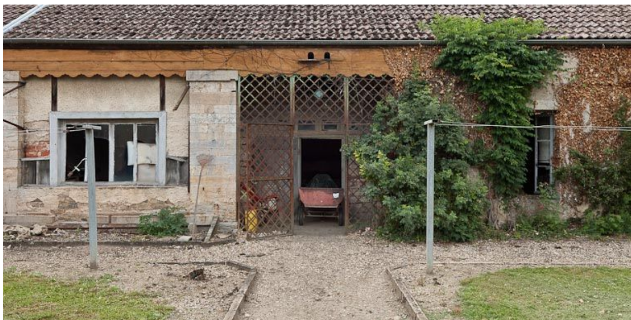
Vue d'un garage dans la cour intérieure.
