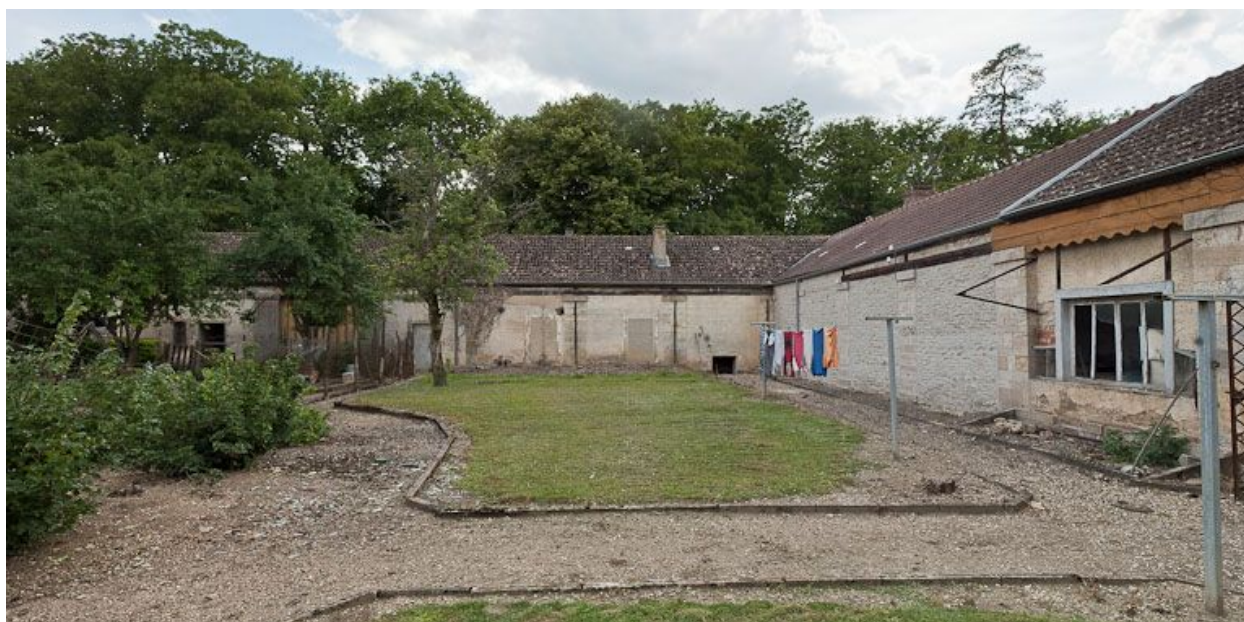
Vue de la cour intérieure.
