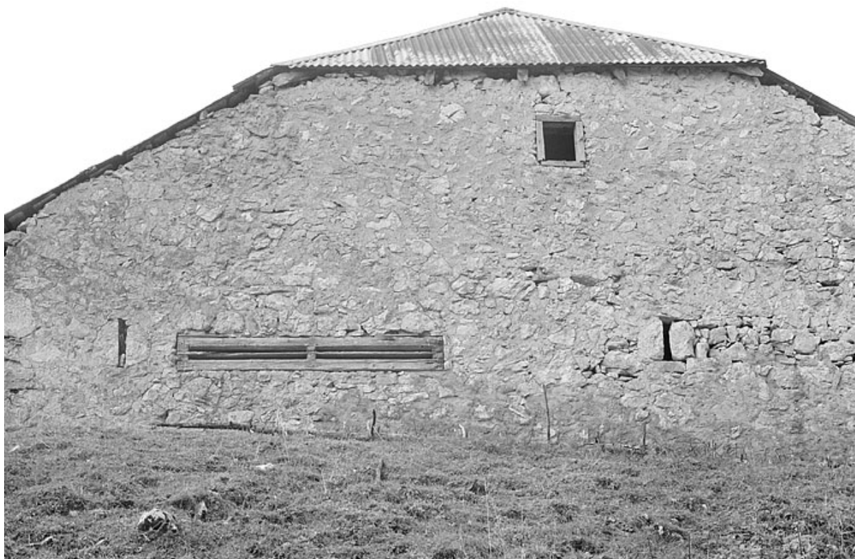
Ouverture en bois pour ventiler la laiterie.
