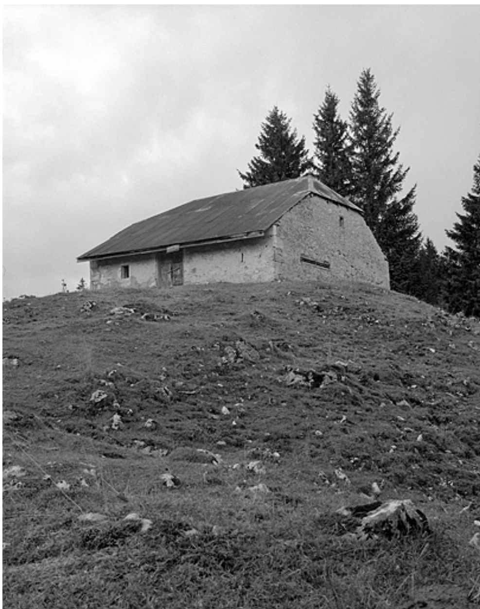
Façade antérieure et face nord-est.
