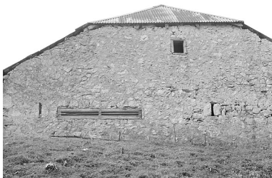
Ouverture en bois pour ventiler la laiterie. Phot. Jérôme Mongreville IVR43_19963901376X
