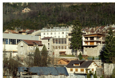
Vue d'ensemble depuis l'ouest. Phot. Laurent Poupard IVR43_19923901369ZA
