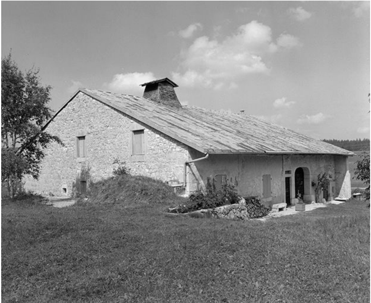
Façades antérieure et latérale gauche.
