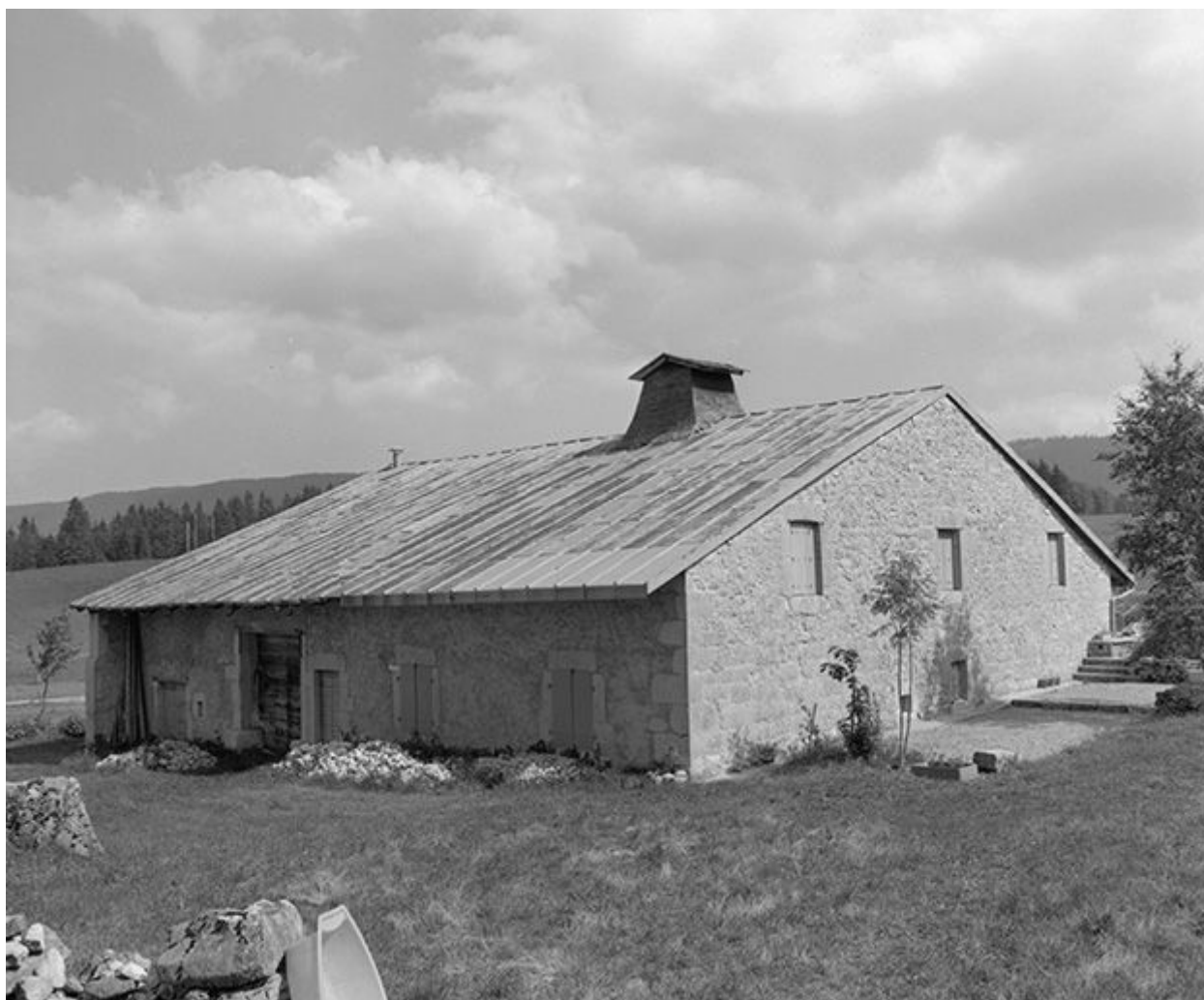
Façades postérieure et latérale droite.
