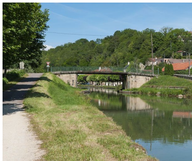
Vue d'ensemble. Phot. Pierre-Marie Barbe-Richaud IVR26_20122101970NUC2AQ
