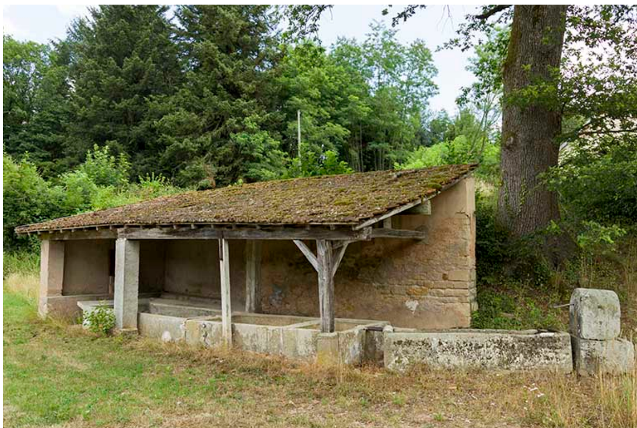
Lavoir, rue des Forges.
