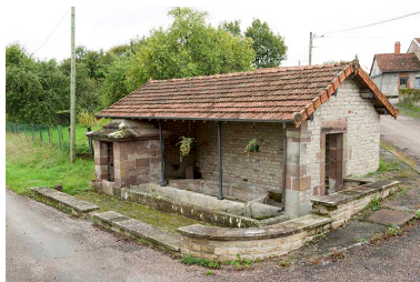
Fontaine-lavoir, rue Jeffroy. Phot. Sonia Dourlot IVR43_20157000566NUC2A
