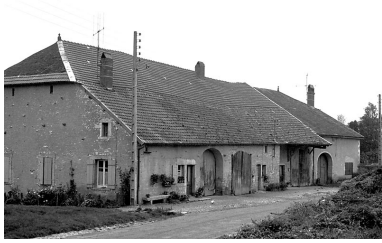
Façades antérieure et latérale gauche.
