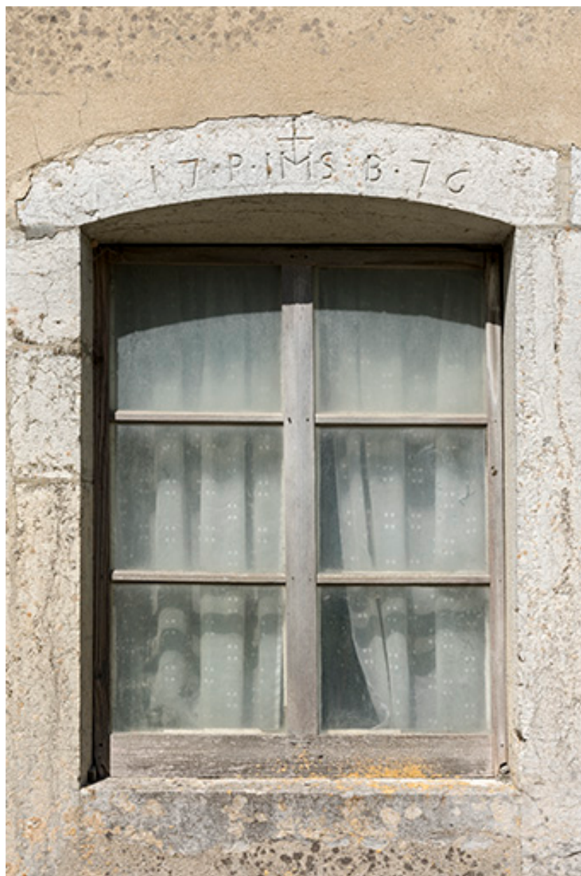
Façade est : fenêtre avec linteau daté 1776.
