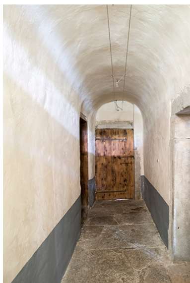
Couloir voûté (côté sud). Phot. Sonia Dourlot IVR43_20172500062NUC4A
