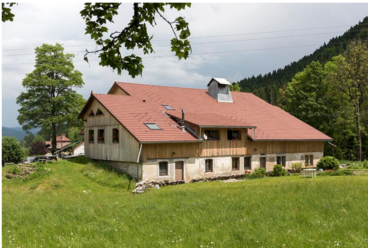
Façades sud et ouest.
