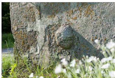
Façade nord : pierre avec relief hémisphérique. Phot. Sonia Dourlot IVR43_20172500674NUC4A
