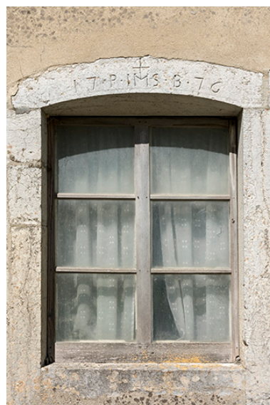
Façade est : fenêtre avec linteau daté 1776.
