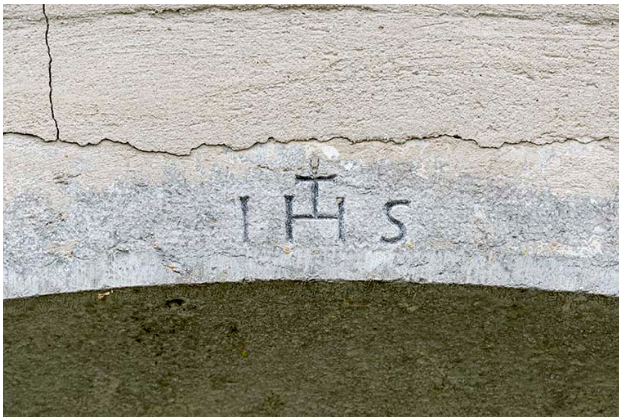
Façade nord : IHS gravé sur un linteau.
