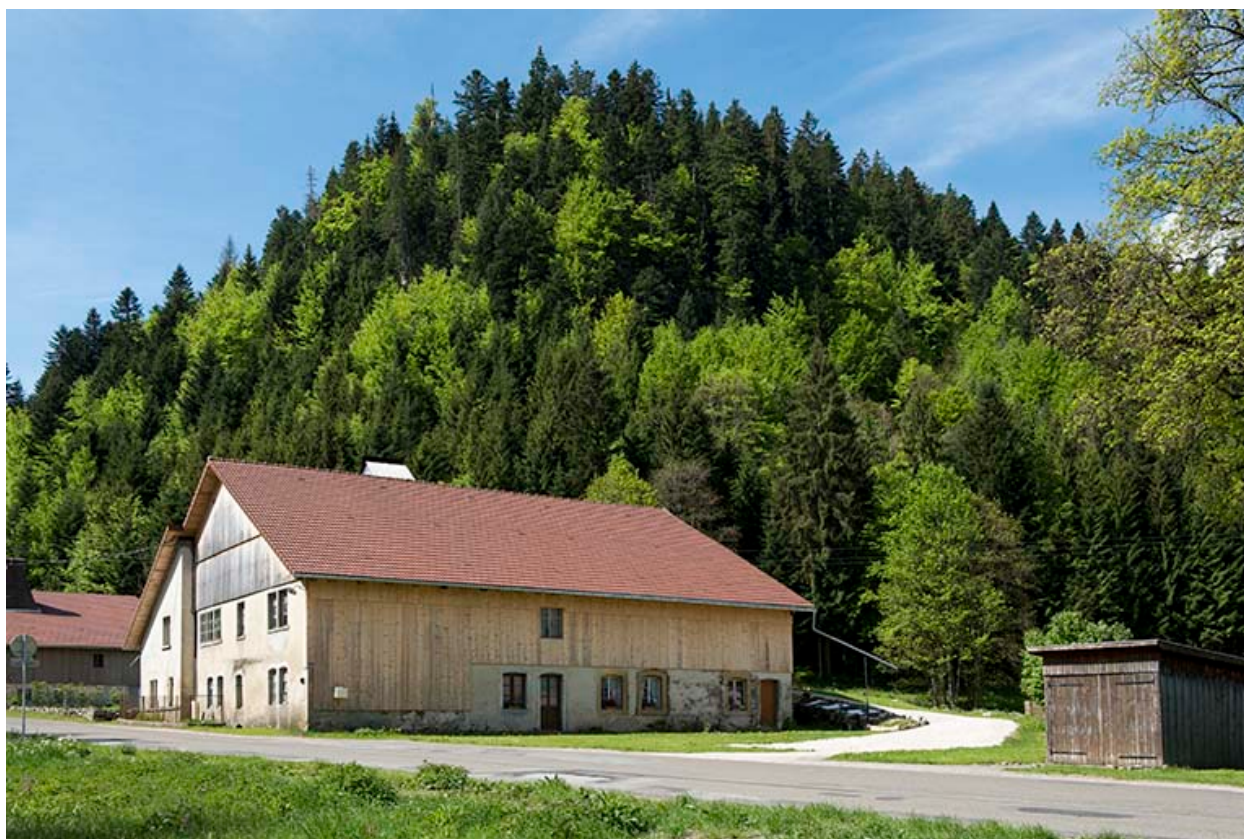
Façades nord et est.
