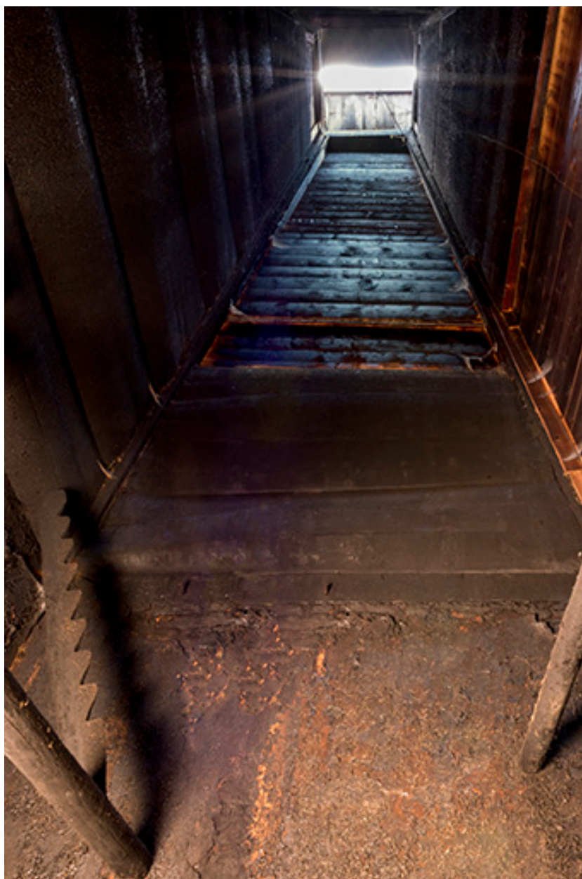
Grand tué : supports des perches et conduit.
