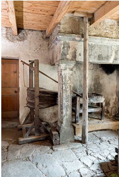
Forge : foyer et soufflet, dans une grande cheminée en pierre. Phot. Sonia Dourlot IVR43_20172500059NUC4A
