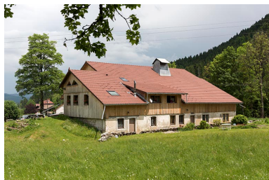
Façades sud et ouest. Phot. Sonia Dourlot IVR43_20172500669NUC4A
