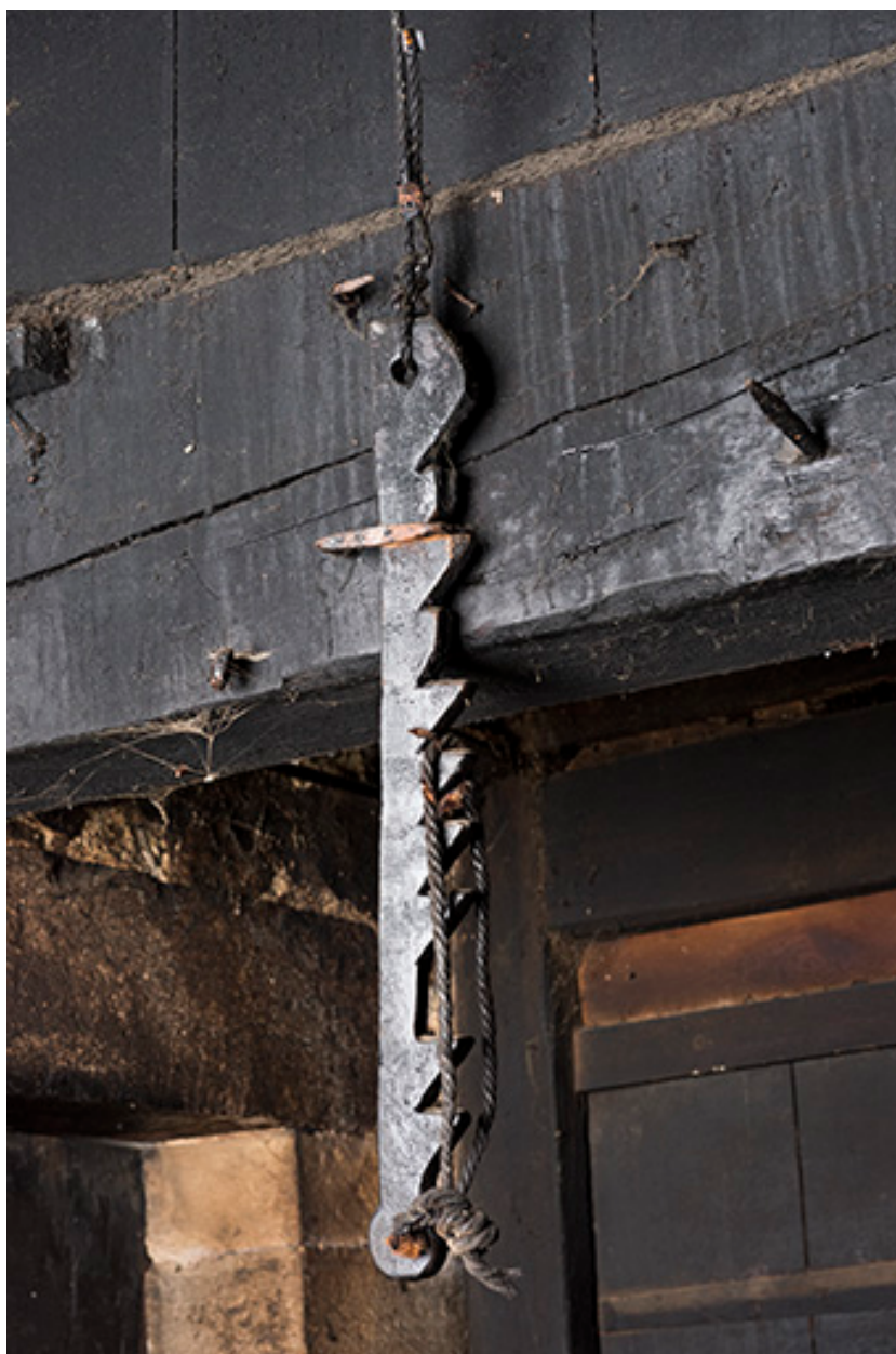
Grand tué : système de fermeture des volets.
