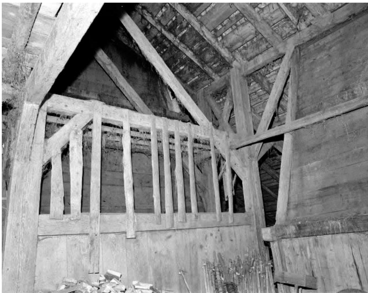
La charpente vue depuis la grange, en 1976.
