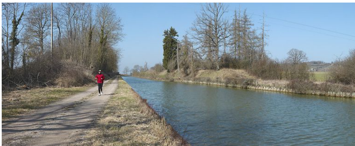
Entrée de la tranchée.
