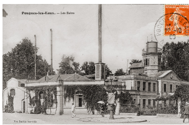
Candélabre installé devant l'entrée de l'établissement thermal en 1899.
