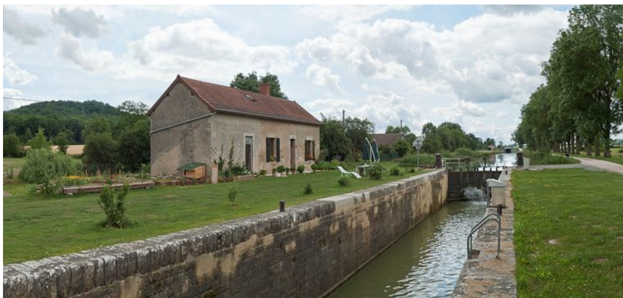
Vue d'ensemble du site d'écluse.
