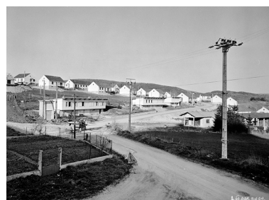
Cité du Closey à Orgelet. Vue générale. Phot. Jérôme Mongreville, Autr. Studios Villeurbannais Monchanin et Périchon IVR43_19913900301X
