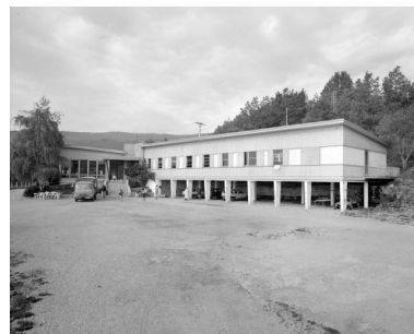
Ancienne cantine.Cantine-foyer à gauche, logement d'ouvriers à droite. Phot. Jérôme Mongreville IVR43_19913900711X
