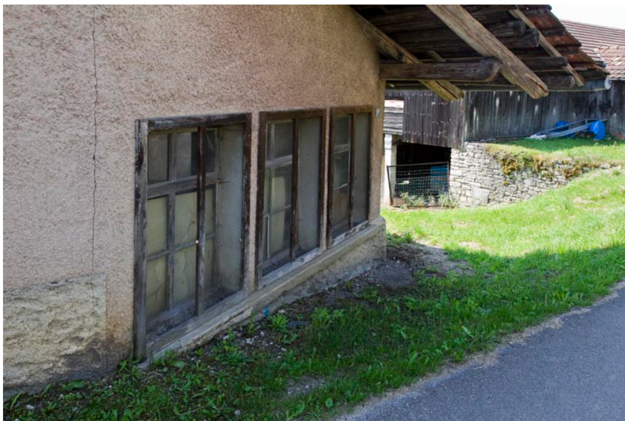
Fenêtres de l'atelier.
