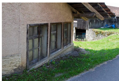
Fenêtres de l'atelier. Phot. Yves Sancey IVR43_20132501200NUC2A
