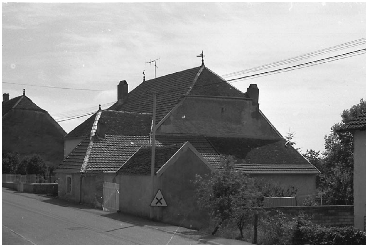
Façade latérale droite.
