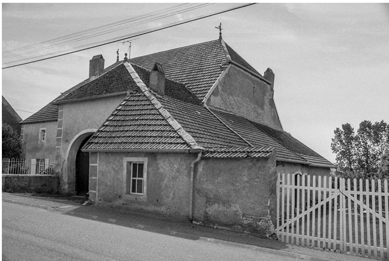
Façade antérieure et latérale droite.
