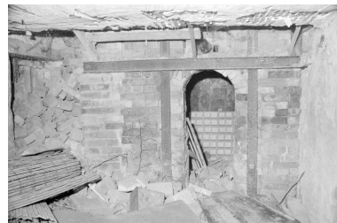
Face antérieure du four. Phot. Laurent Poupard IVR43_19883900342Z
