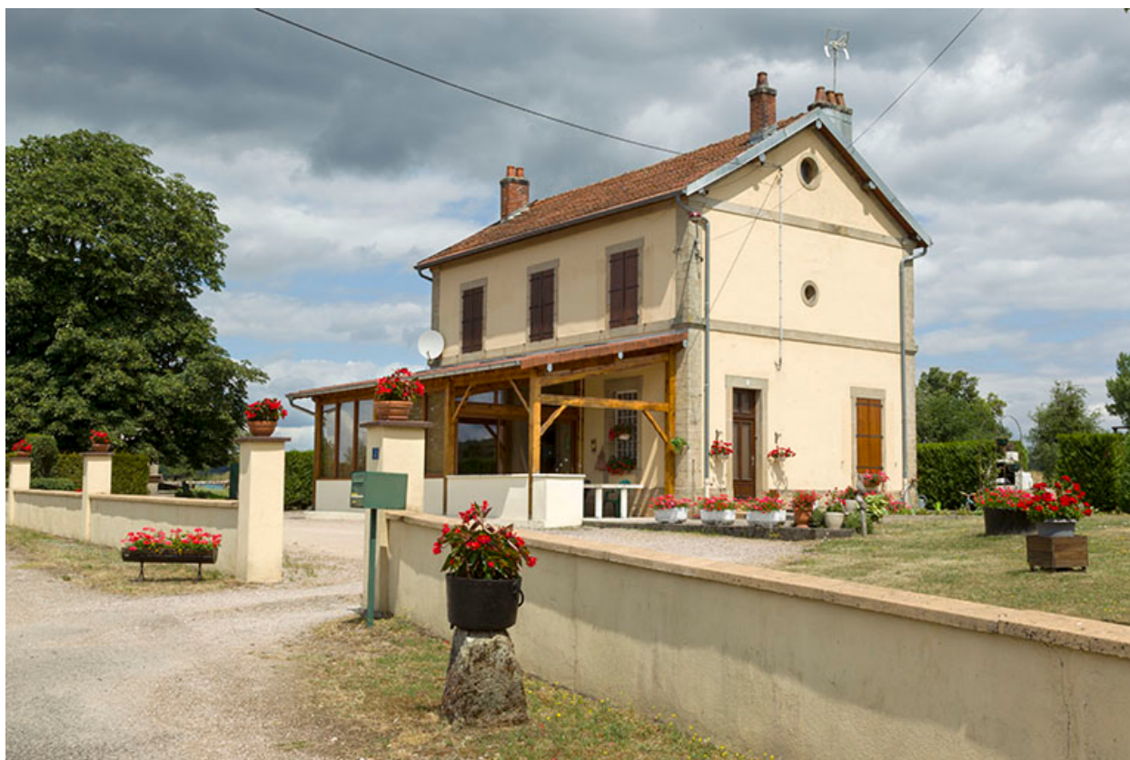
L'ancienne gare transformée en maison d'habitation.
