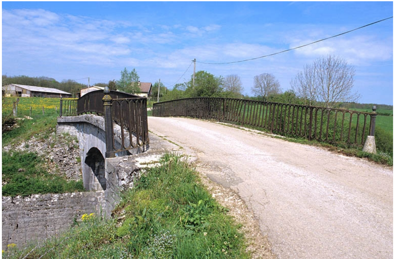
Tablier et garde-corps, depuis le nord-ouest.
