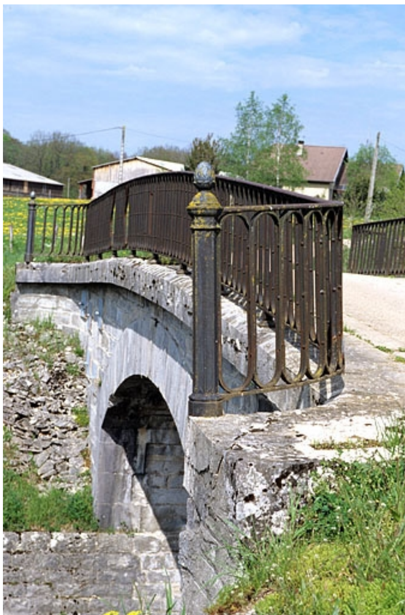
Vue d'ensemble du garde-corps nord.
