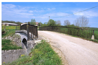
Tablier et garde-corps, depuis le nord-ouest. Phot. Yves Sancey IVR43_20053900039ZA
