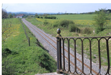
Potelet est du garde-corps sud. Phot. Yves Sancey
