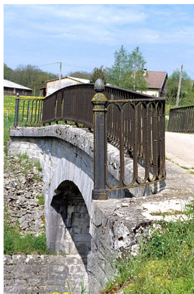
Vue d'ensemble du garde-corps nord. Phot. Yves Sancey IVR43_20053900040ZA
