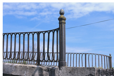
Potelet ouest du garde-corps nord. Phot. Yves Sancey IVR43_20053900044ZA
