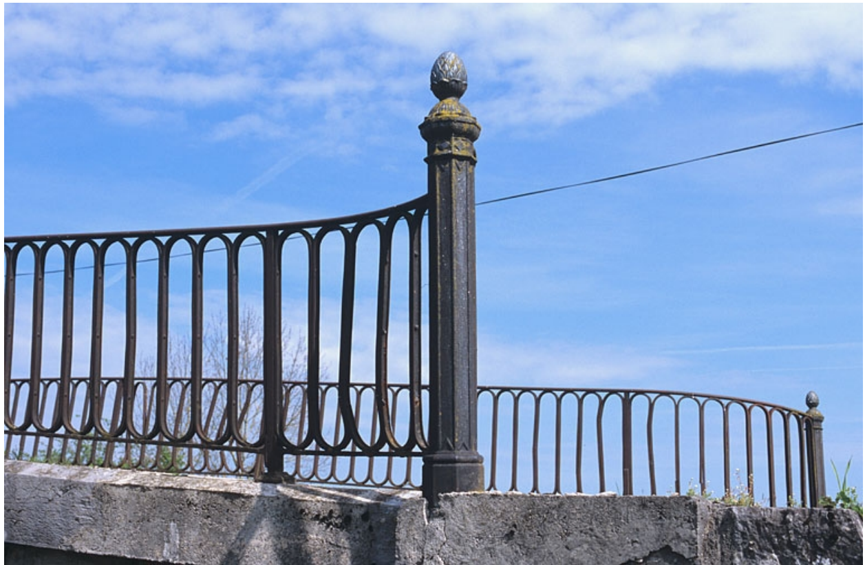
Potelet ouest du garde-corps nord.
