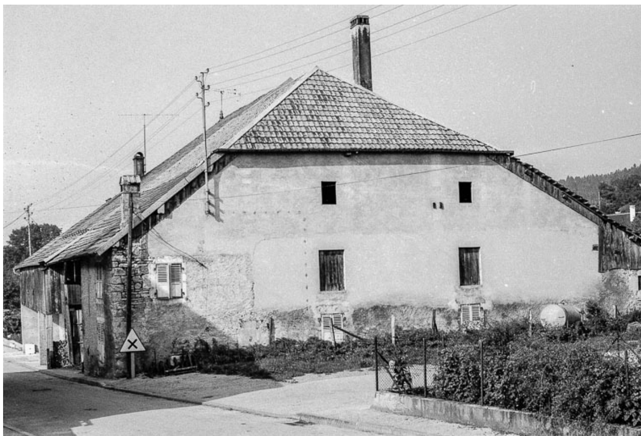
Ferme : façade latérale droite.
