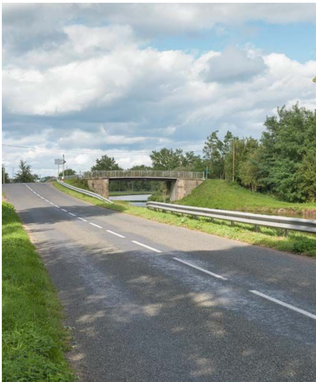
Vue d'ensemble du pont.
