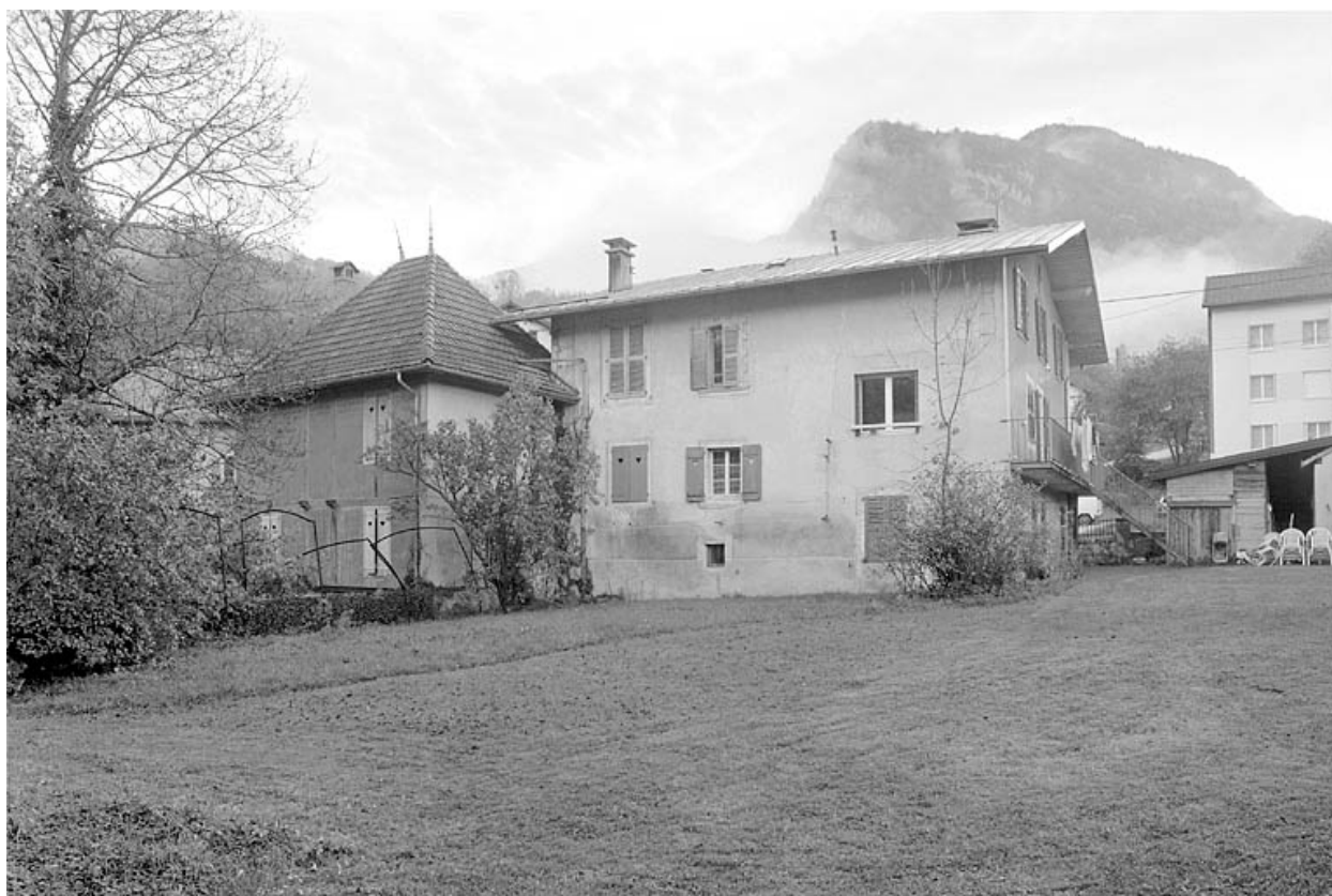
Façade postérieure de l'ensemble.
