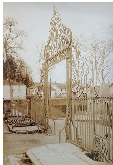
Vue de la grille avant sa dépose.
