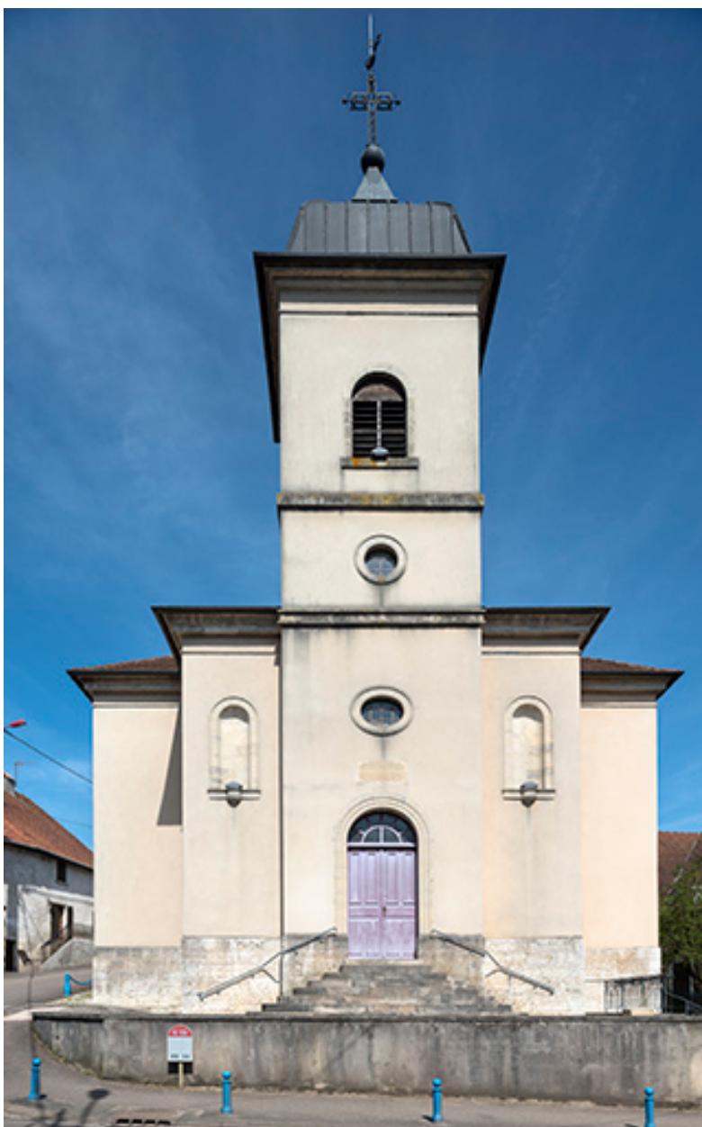
La façade antérieure de la chapelle.
