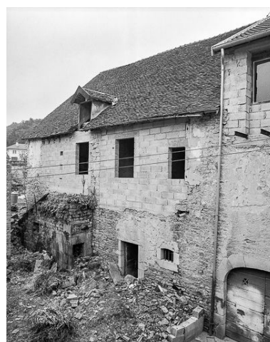
Façade postérieure. Phot. Yves Sancey IVR43_19843900243X
