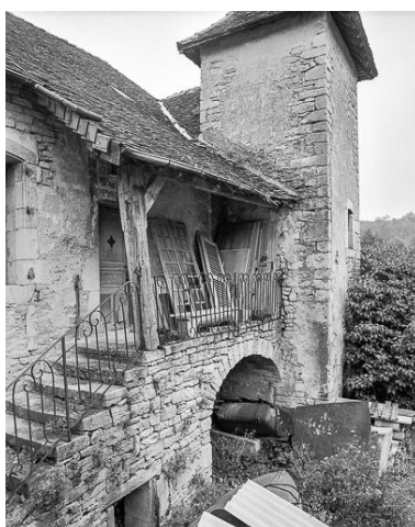
Auvent protégeant l'escalier. Phot. Yves Sancey IVR43_19843900242X
