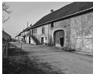
Ferme située rue du Puits. Phot. Jérôme Mongreville IVR43_19853900080X
