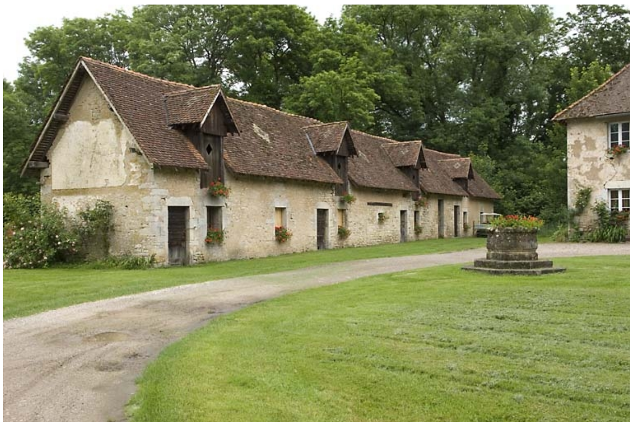
Logement ouvrier vu depuis le nord.
