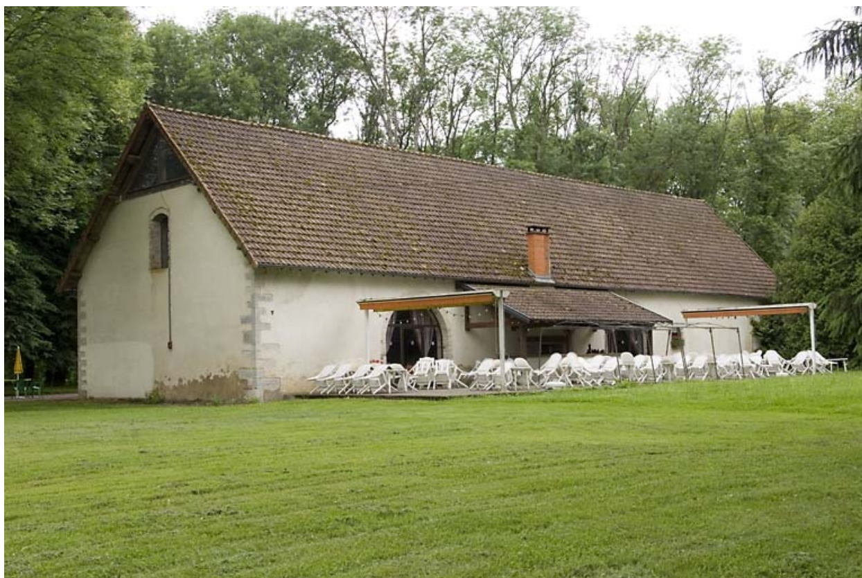
Ancienne halle à charbon depuis le sud.
