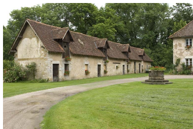
Logement ouvrier vu depuis le nord.
