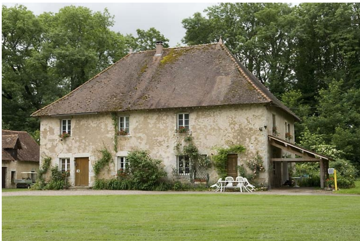
Logement patronal vu de trois quarts droite.
