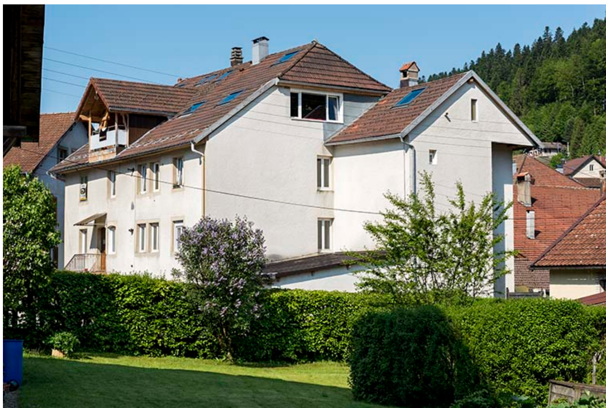
Façades antérieure et latérale droite.
