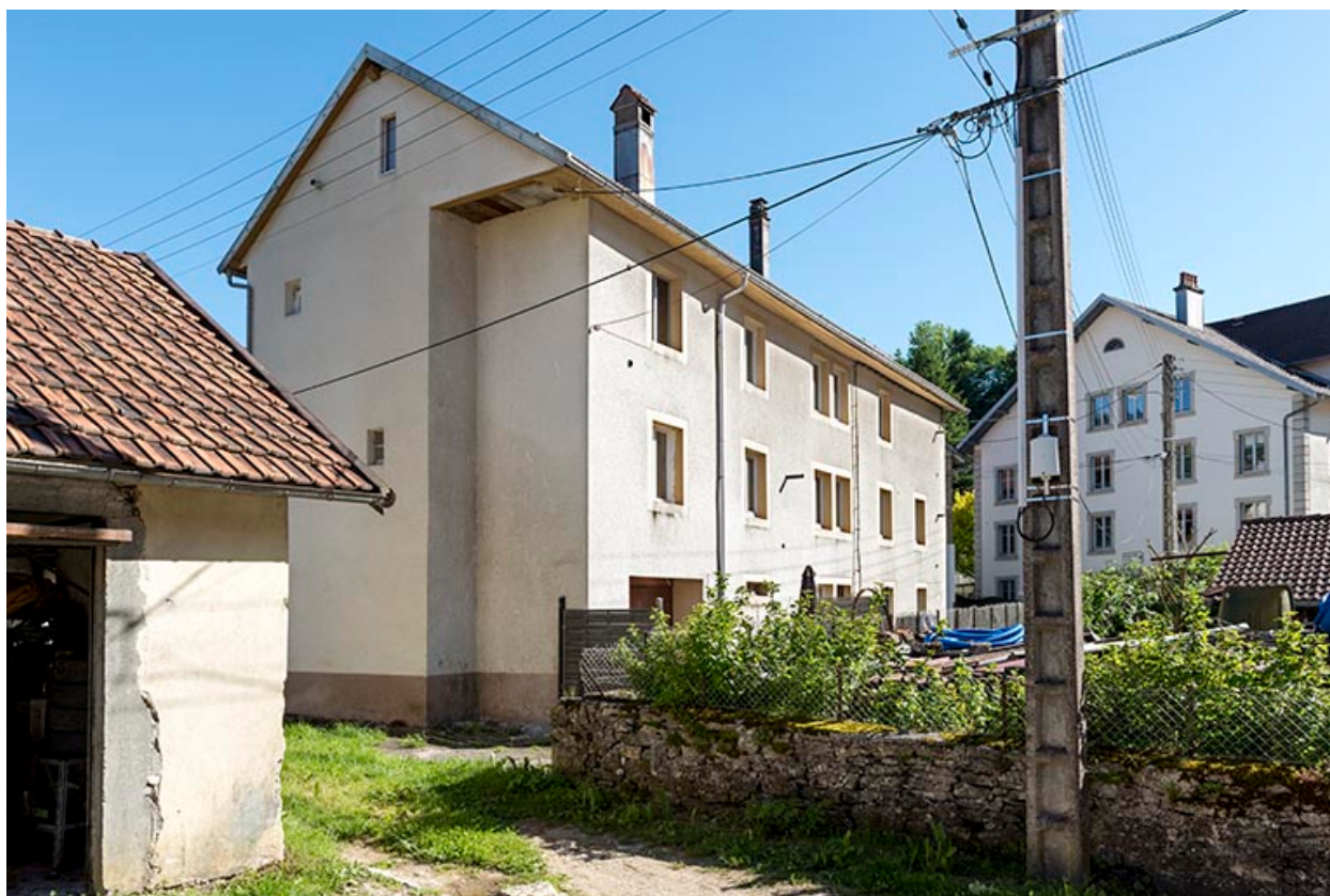
Façades postérieure et latérale droite.
