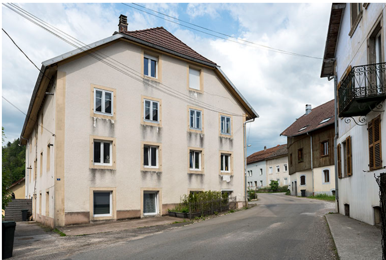
Façade latérale gauche (sud).
