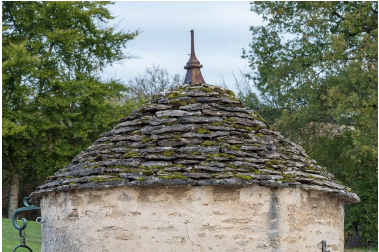
Détail de la toiture.
