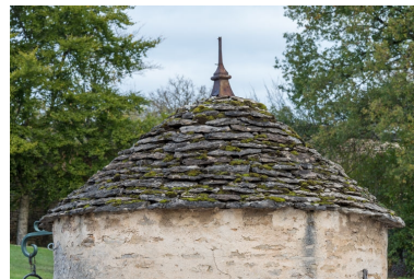
Détail de la toiture. Phot. Pierre-Marie Barbe-Richaud IVR26_20222101053NUC4A
