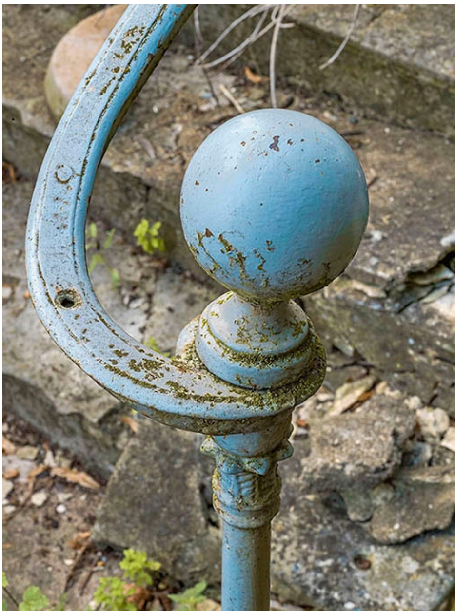
Départ de rampe : détail.
