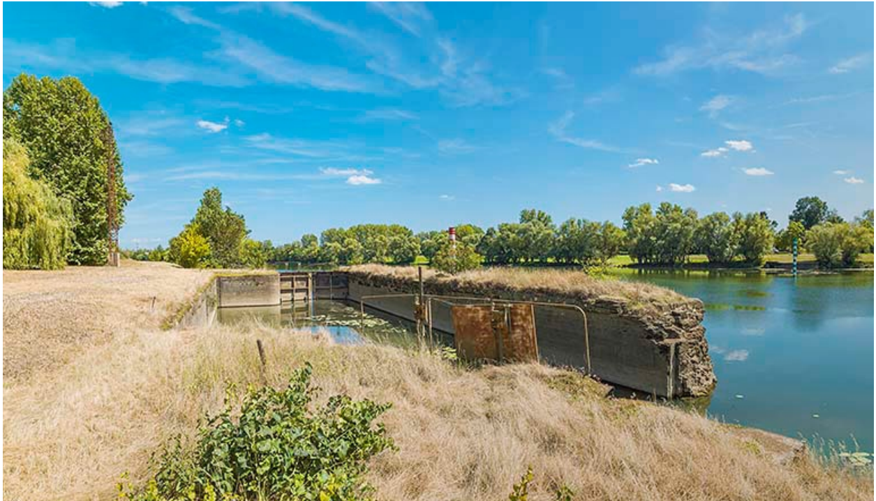
Le sas de l'ancienne écluse de Verdun.
