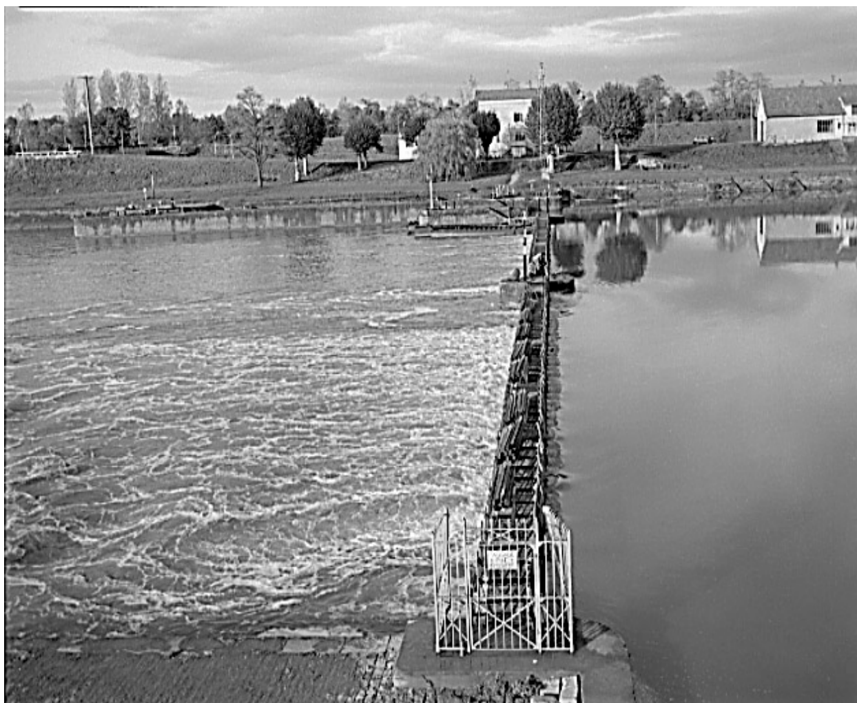
Vue d'ensemble du barrage (en 1986).
