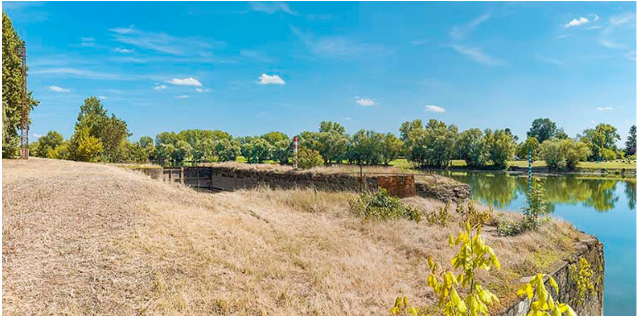
L'ancienne écluse de Verdun au premier plan.
