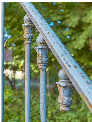
Détail des balustres du garde-corps de l'escalier. Phot. Thierry Kuntz IVR26_20207100189NUC4A
