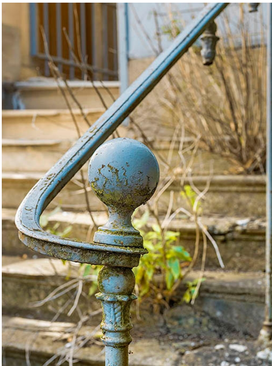
Départ de rampe : détail.
