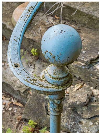
Départ de rampe : détail. Phot. Thierry Kuntz IVR26_20207100188NUC4A
