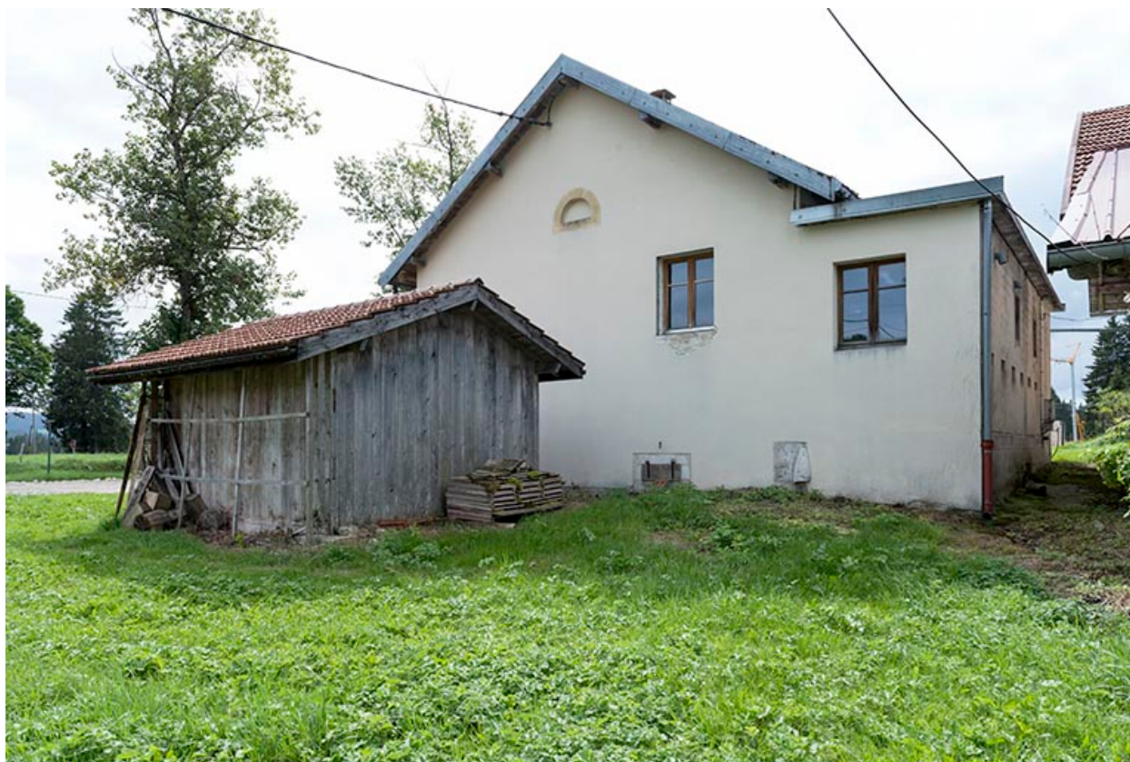
Fromagerie : façade latérale droite.
