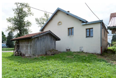
Fromagerie : façade latérale droite.
