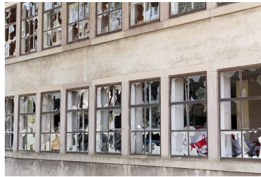
Détail des baies de la façade postérieure. Phot. Jérôme Mongreville IVR43_20112501414NUC4A
