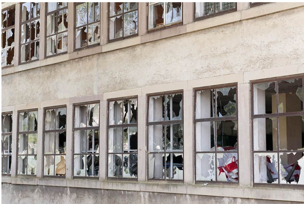
Détail des baies de la façade postérieure.
