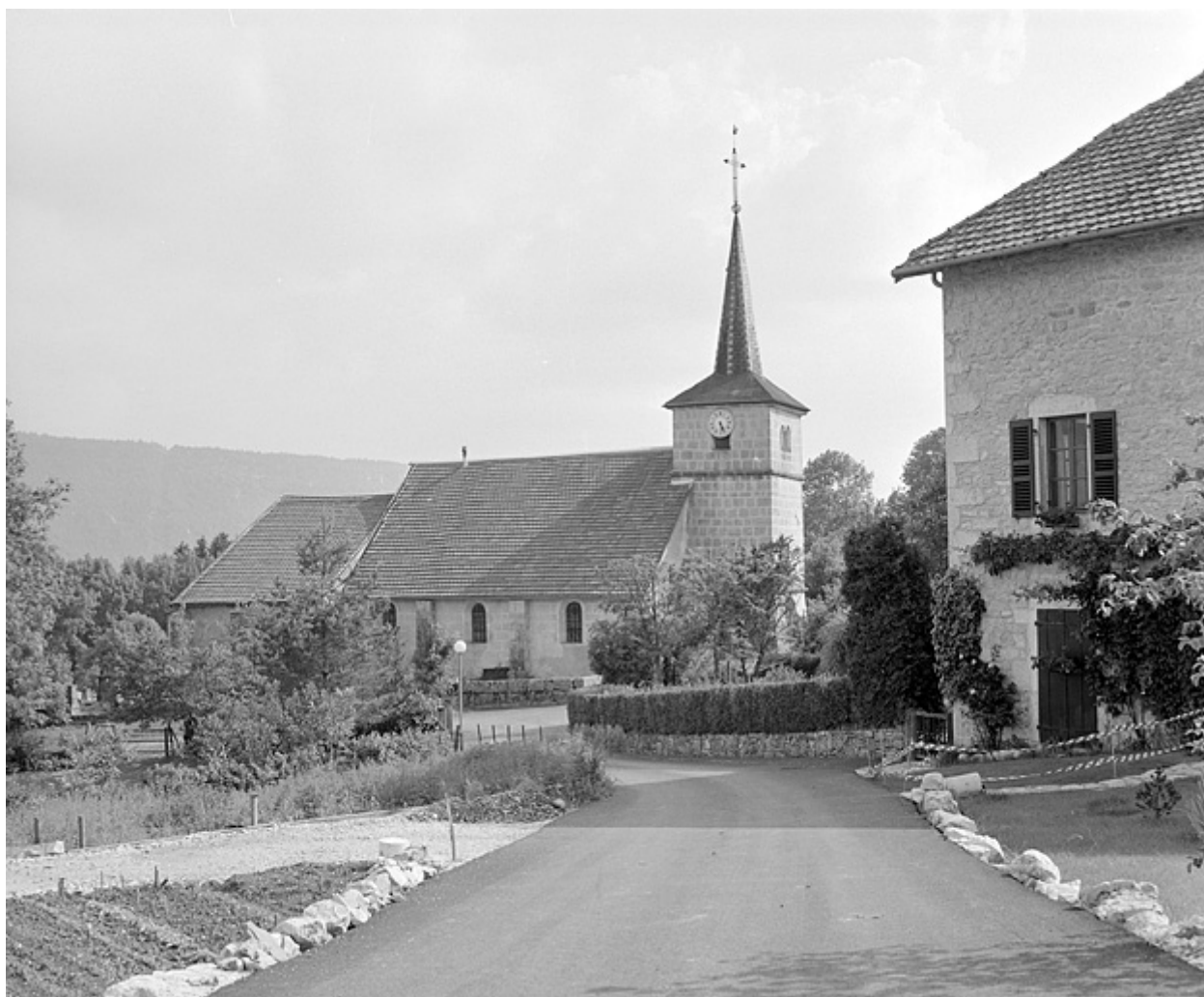
Vue de situation depuis le nord-ouest.
