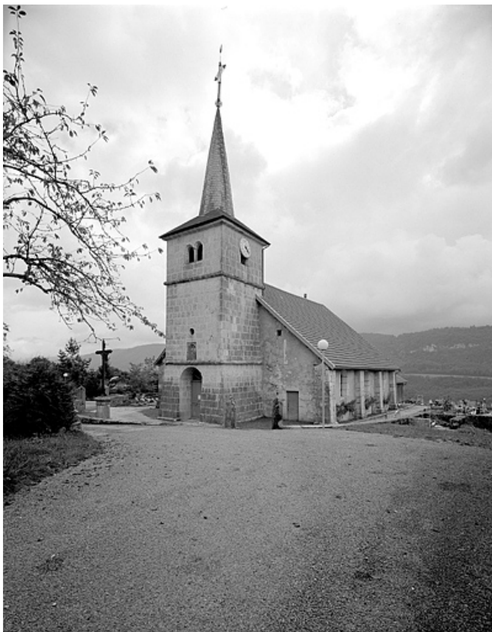
Façade antérieure et face droite.
