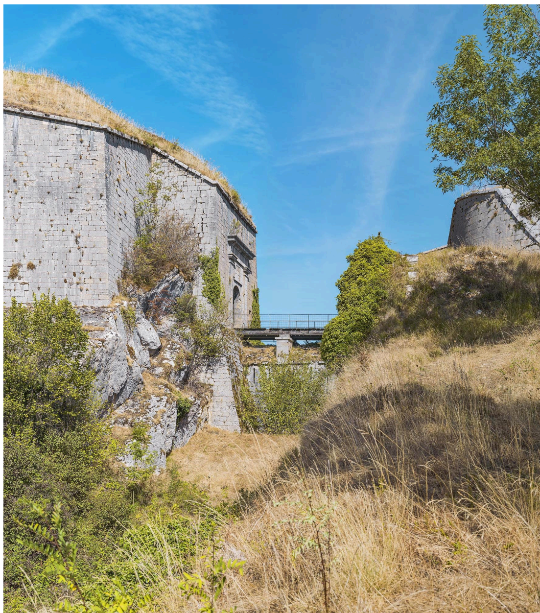
Caponnière dans le fossé.
