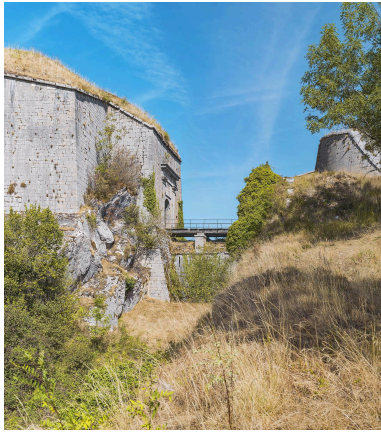
Caponnière dans le fossé. Phot. Thierry Kuntz IVR43_20223901117NUC4A
