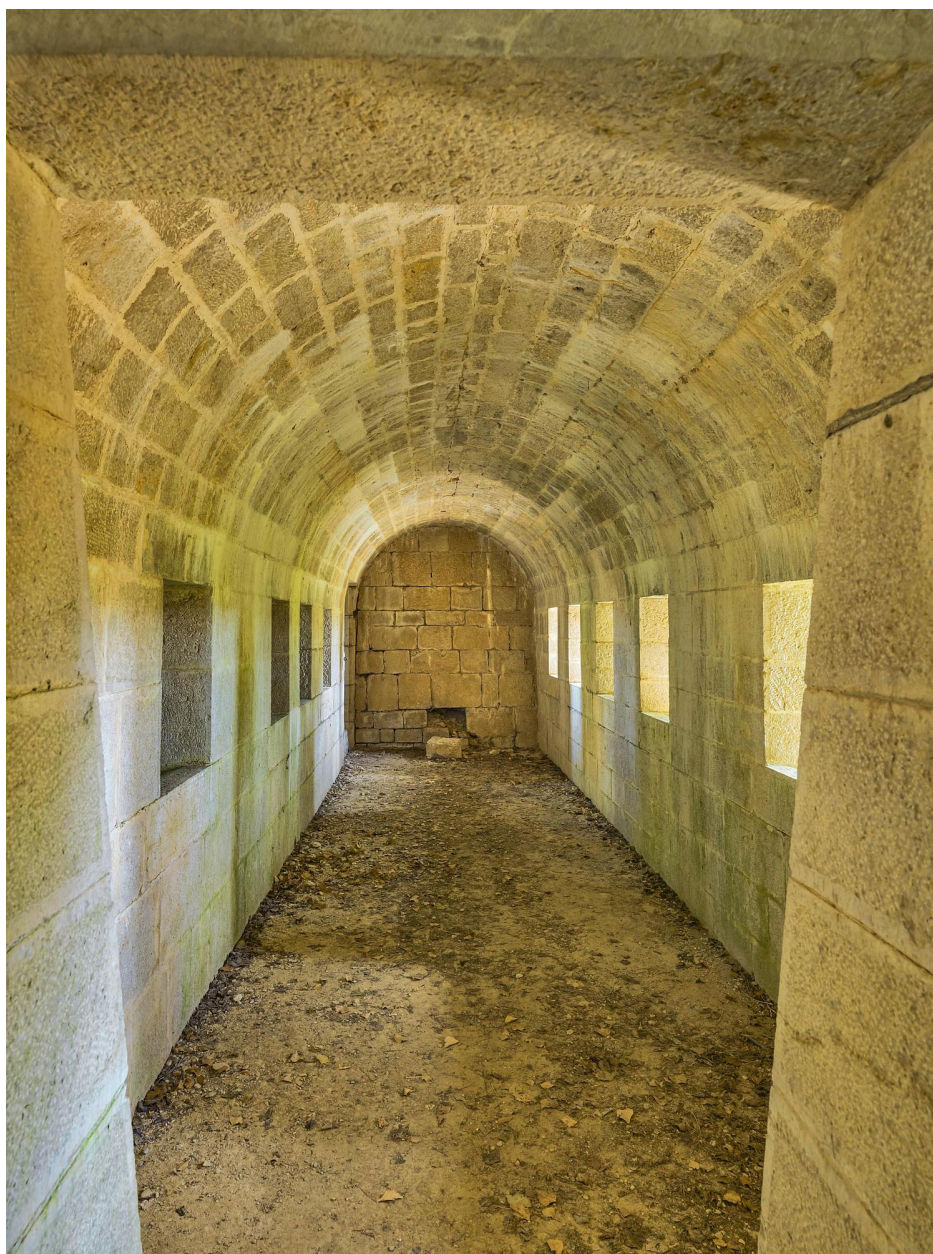
Caponnière flanquant l'intérieur du fossé.
