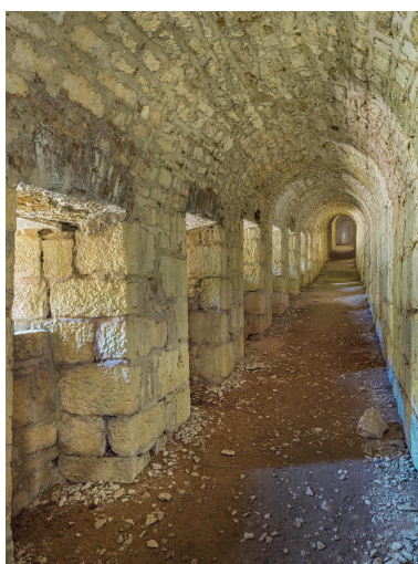
Galerie de la contrescarpe. Phot. Thierry Kuntz IVR43_20223901087NUC4A
