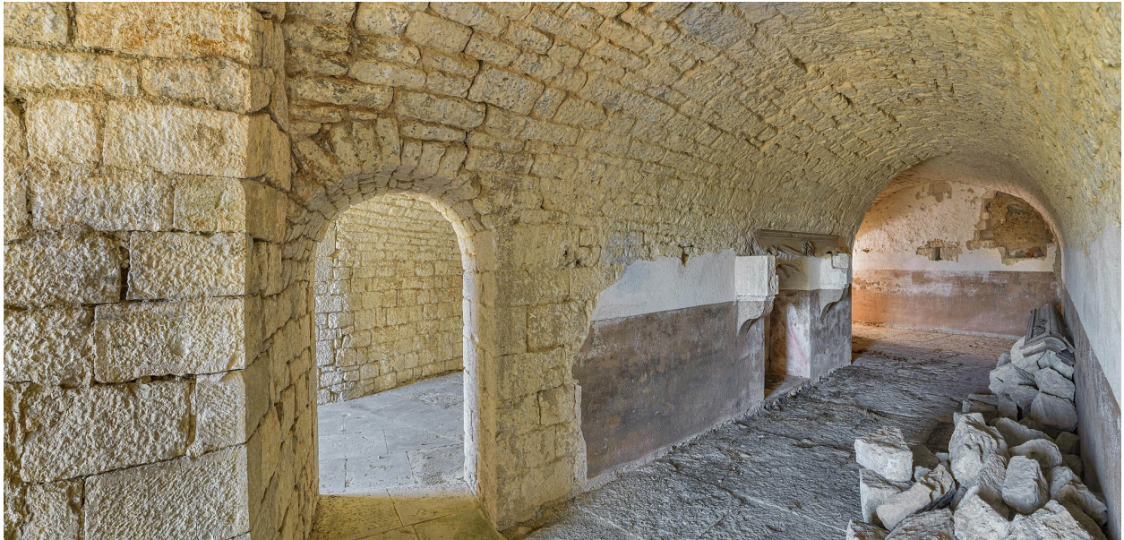
Salle casematée de l'étage avec cheminée.
