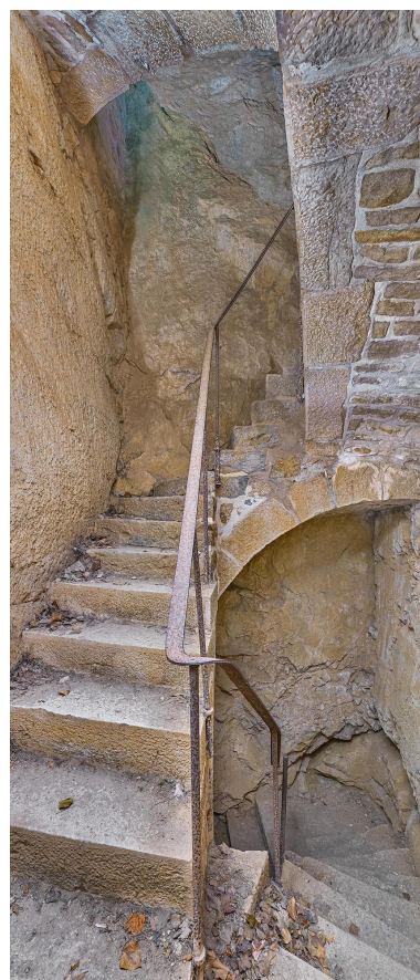
Escalier desservant les étages inférieurs. Phot. Thierry Kuntz IVR43_20223901085NUC4A
