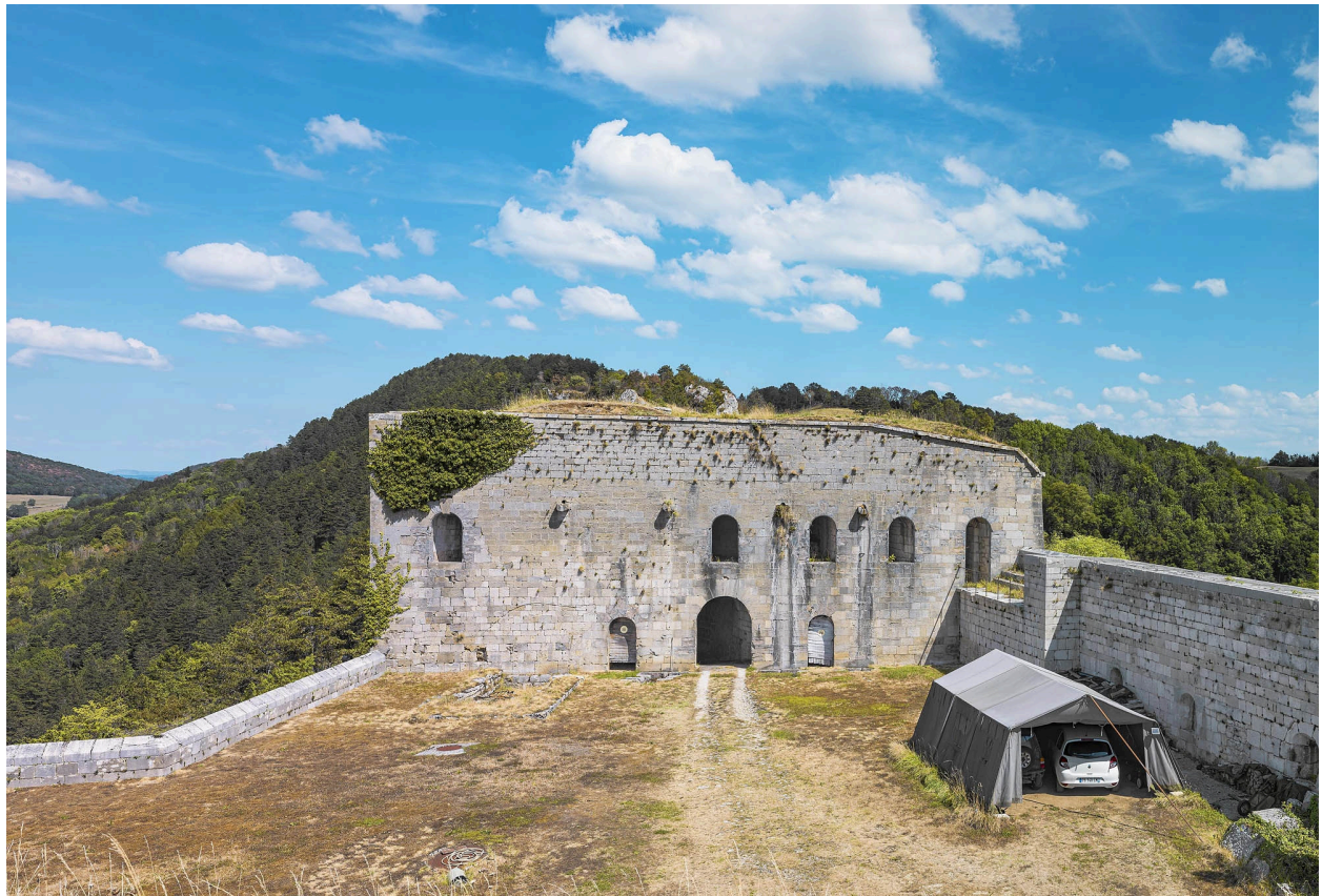
La façade postérieure.
