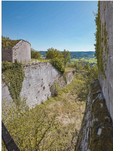
Le mur de contrescarpe et le fossé. Phot. Thierry Kuntz IVR43_20223901113NUC4A
