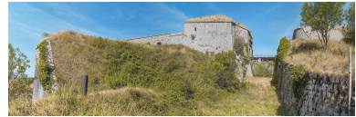
De gauche à droite : aile de l'ouvrage à cornes, le cavalier, le fossé, la contrescarpe et le réduit protégeant l'entrée du fort. Phot. Thierry Kuntz IVR43_20223901114NUC4A
