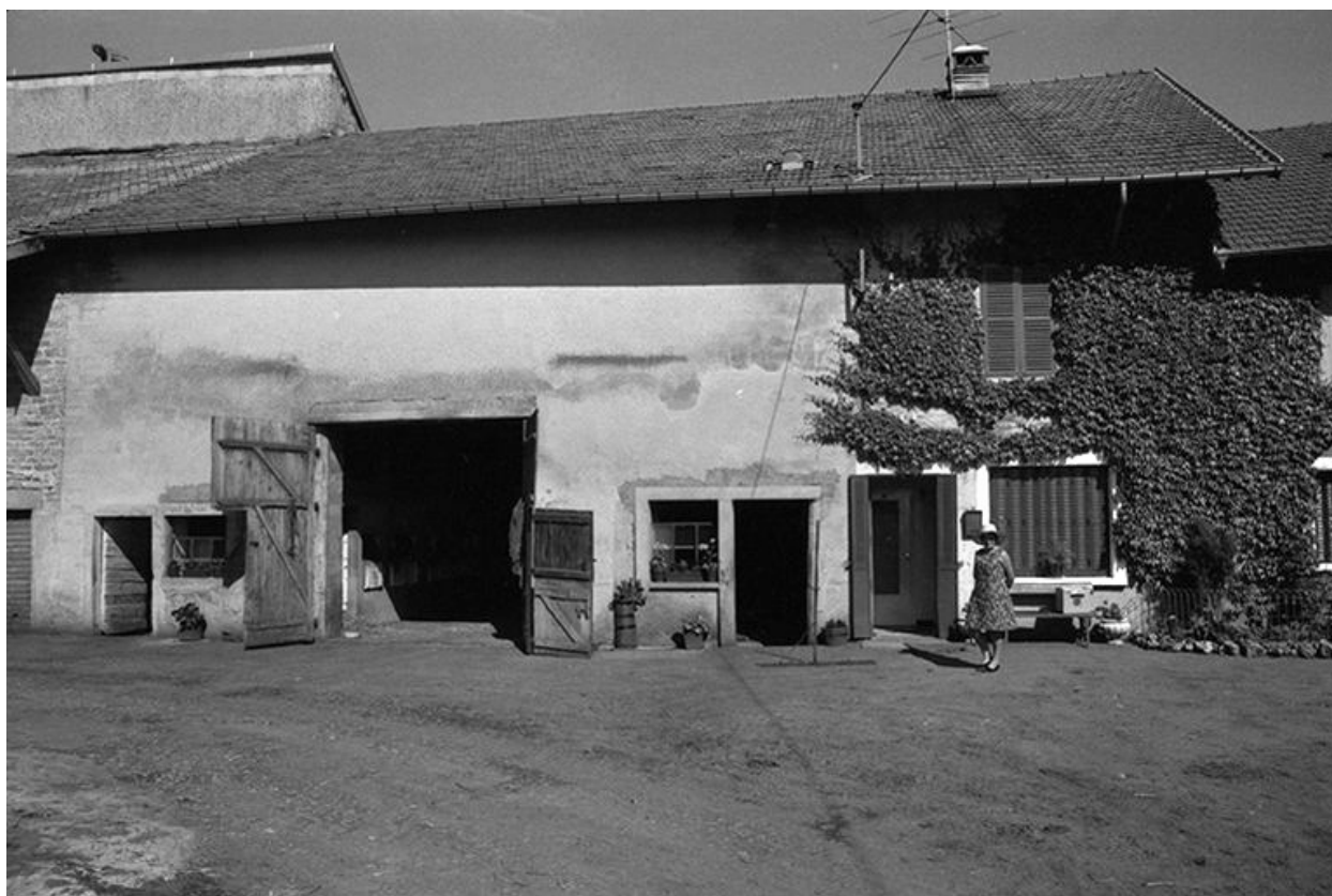
Ferme cadastrée 1957 A1 64 : façade antérieure.
