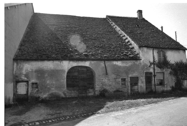
Ferme cadastrée 1957 A1 323 située le long du chemin vicinal n° 2 de La Marre à Poligny : façade antérieure. A noter le toit à "pas de moineaux". Phot. F. Pernin IVR43_19743900220Z
