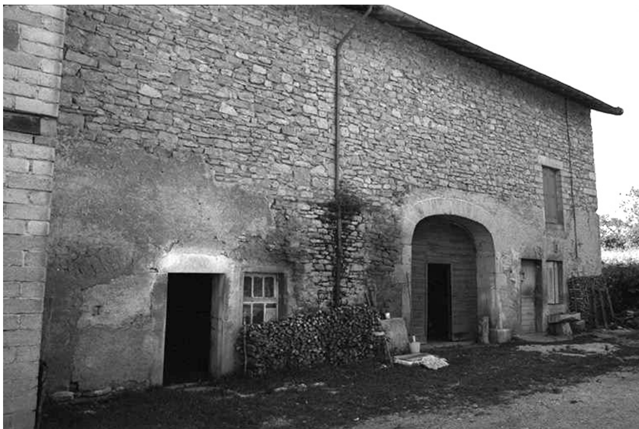
Ferme cadastrée 1957 A1 232 : façade antérieure.
