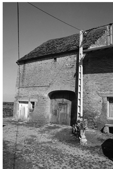
Ferme cadastrée 1957 A1 85, située le long du chemin de grande communication n° 96 de Plasne à Mirebel : parties agricoles. A noter le toit de laves. Phot. F. Pernin IVR43_19743900202Z
