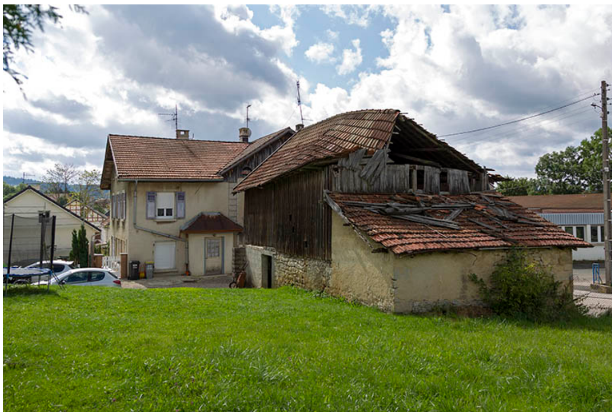
Remise et logement patronal (façade latérale gauche).
