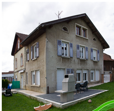
Logement patronal : façades postérieure et latérale droite. Phot. Sonia Dourlot IVR43_20142501851NUC4AQ
