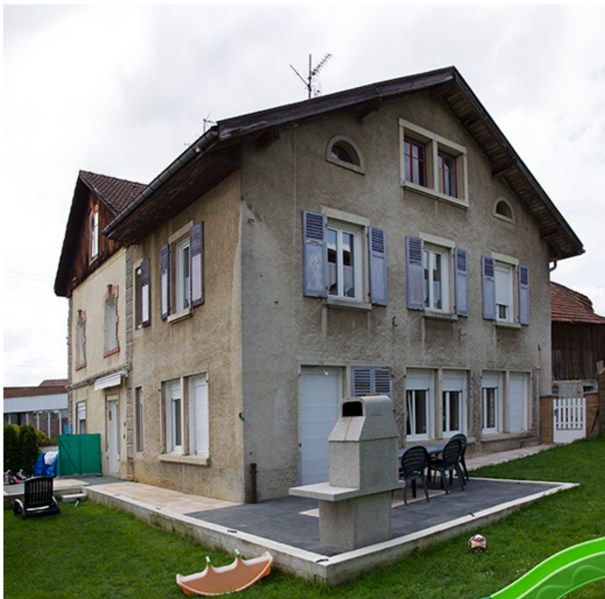
Logement patronal : façades postérieure et latérale droite.
