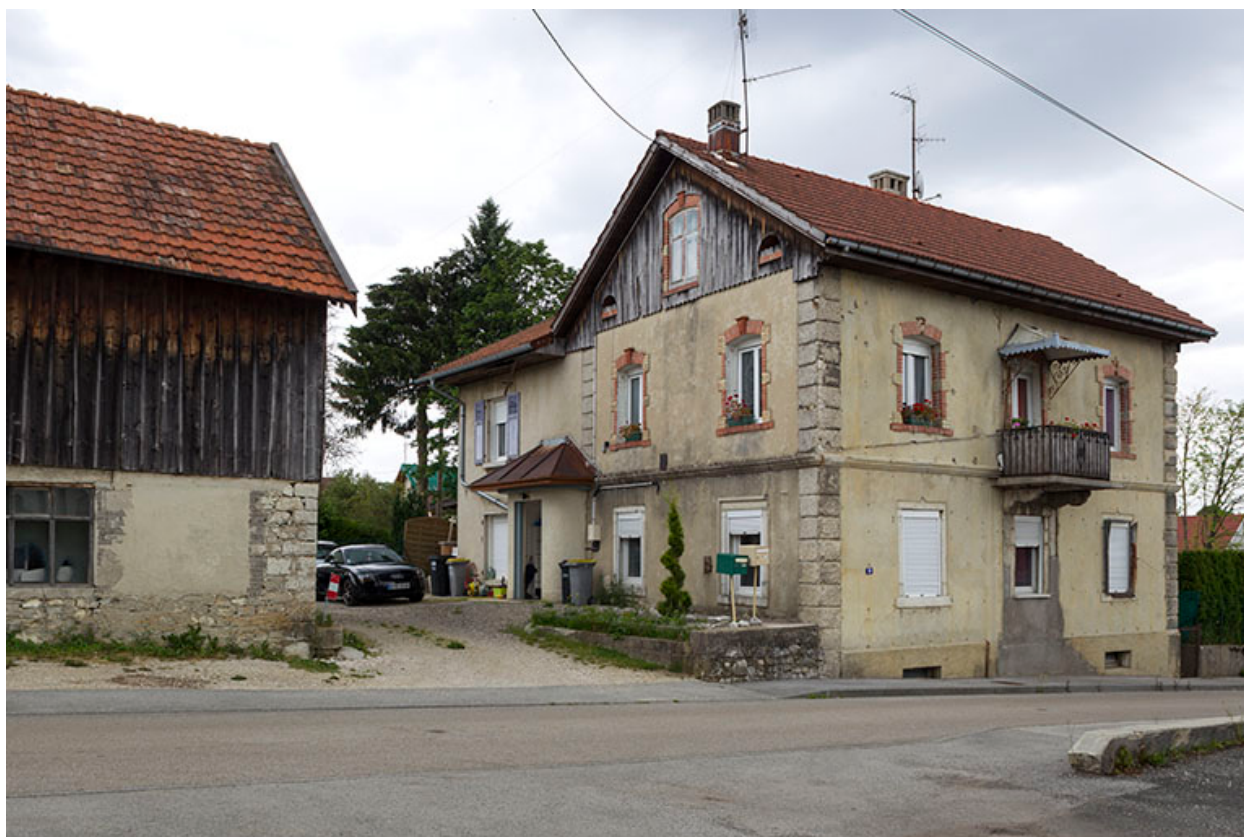
Logement patronal : façades antérieure et latérale gauche.
