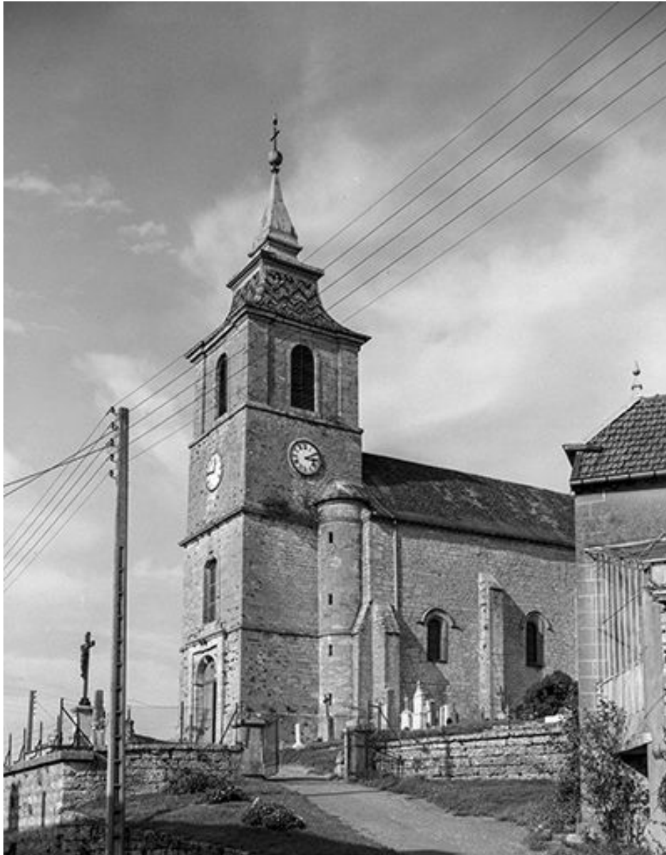
Tour-clocher et façade latérale droite.
