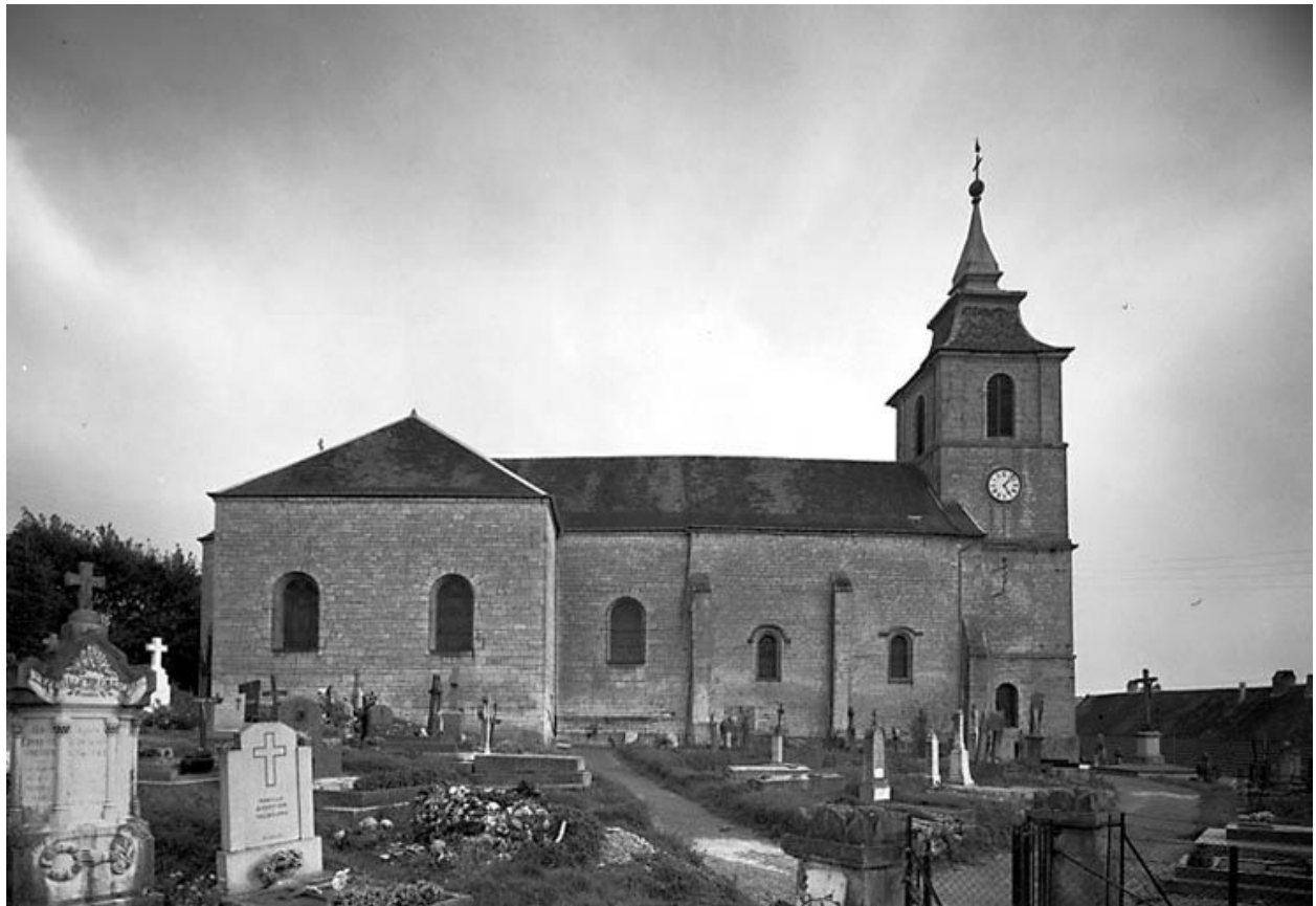
Façade latérale gauche.
