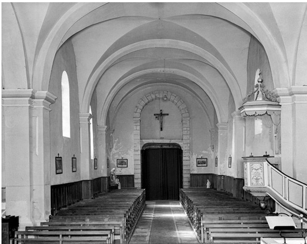
La nef vue du chœur.
