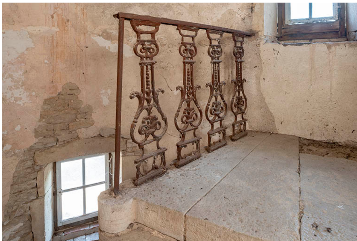
Escalier en vis, comble.
