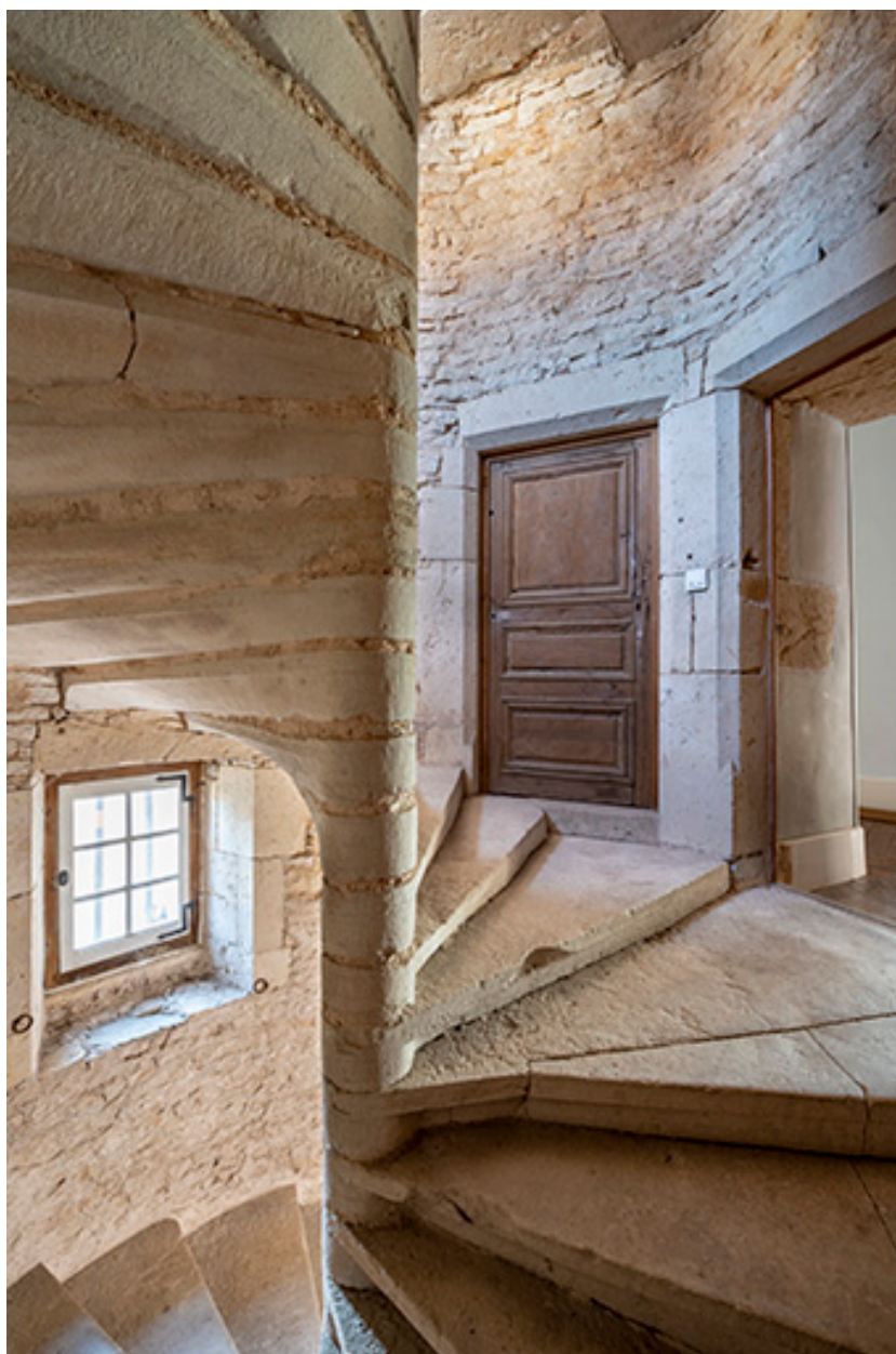
Escalier en vis, premier étage.
