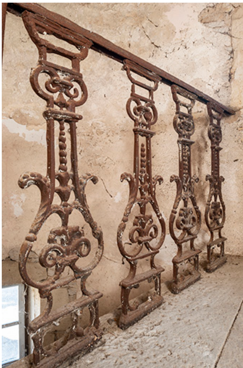
Garde-corps à motif de balustres en ferronnerie.
