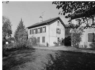
Logements depuis le sud-est. Phot. Yves Sancey IVR43_20022500690X
