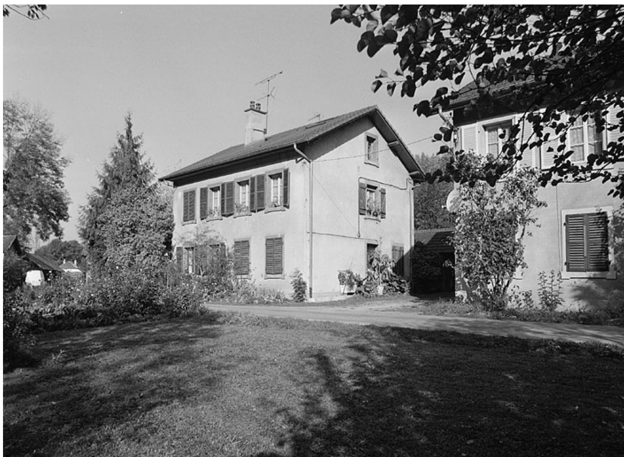
Logements depuis le sud-est.
