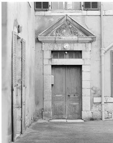
La porte d'entrée de l'ancien presbytère. Phot. Jérôme Mongreville IVR43_19963901304X
