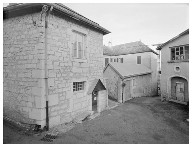
Face sud-ouest. Phot. Jérôme Mongreville IVR43_19963901697V
