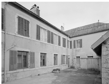
Cour intérieure : logis de la cure. Phot. Jérôme Mongreville IVR43_19963901698V
