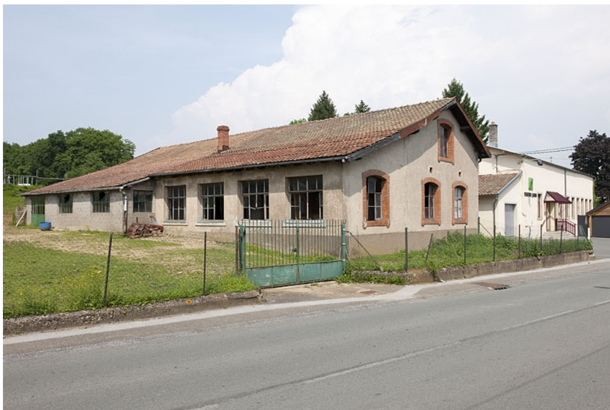
Vue d'ensemble depuis l'ouest.
