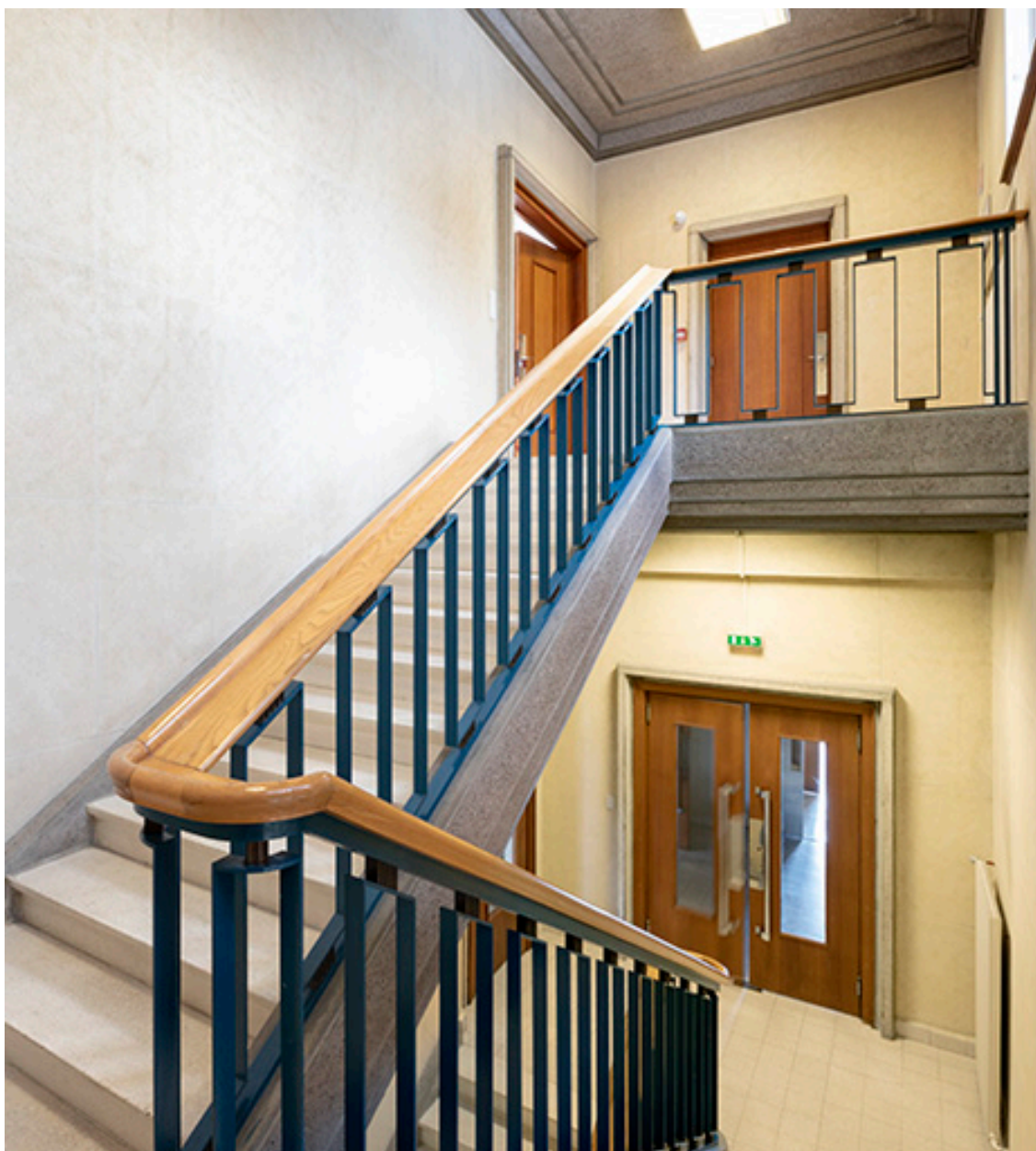
Rez-de-chaussée, corps central : escalier, depuis le repos.
