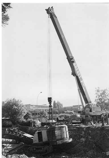
[Construction du laboratoire de métrologie, fondations : sortie à l'aide d'une grue de la sonnette utilisée pour le battage des pieux], 1981. IVR43_20192500520NUC2A
