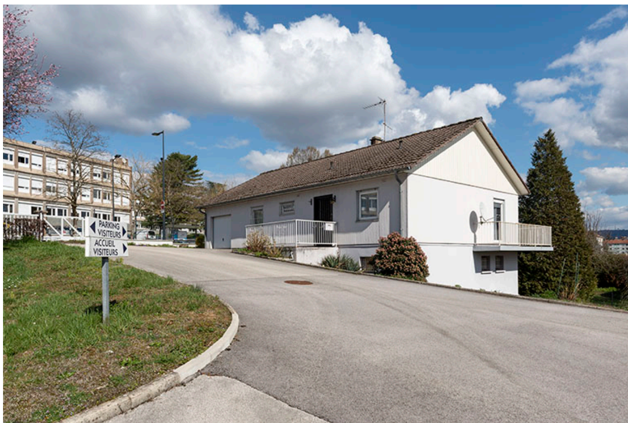
Conciergerie, depuis le sud-ouest.
