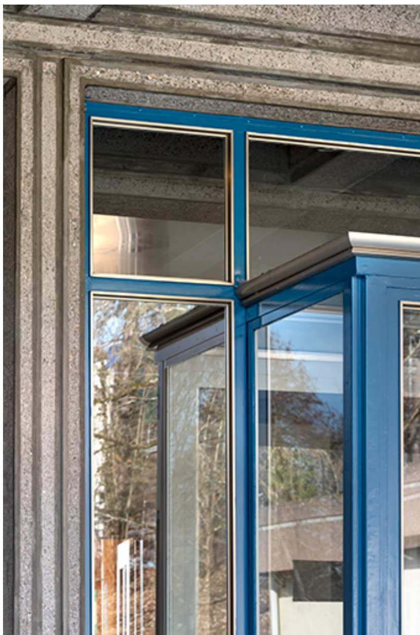
Façade antérieure, corps central : détail de l'entrée.
