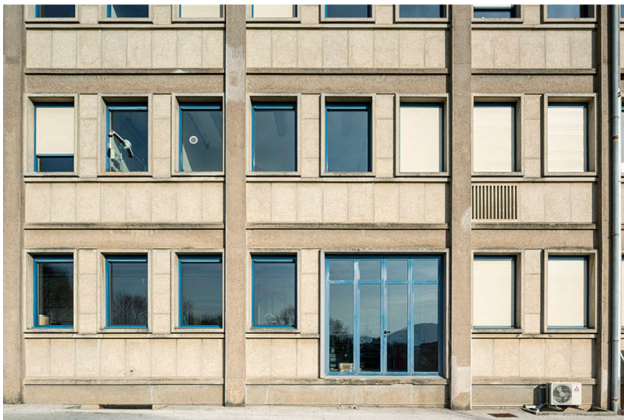
Façade postérieure, corps oriental : travées.
