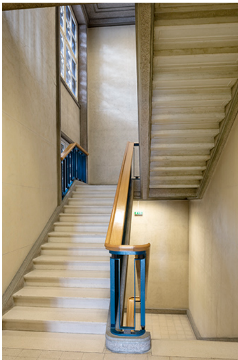
Rez-de-chaussée, corps central : escalier.
