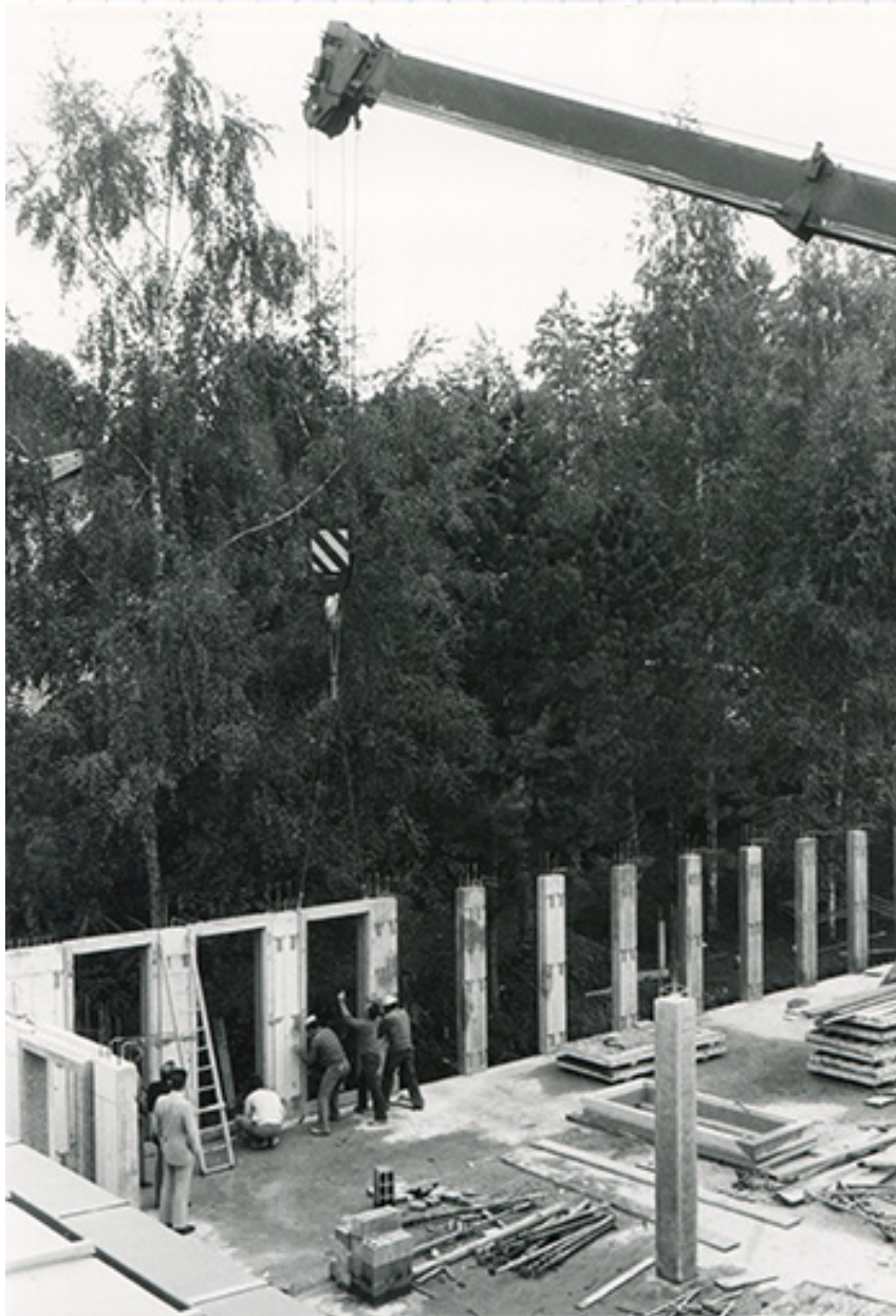
[Construction du laboratoire de métrologie, rez-de-chaussée : pose d'un élément du mur occidental], 1981.
