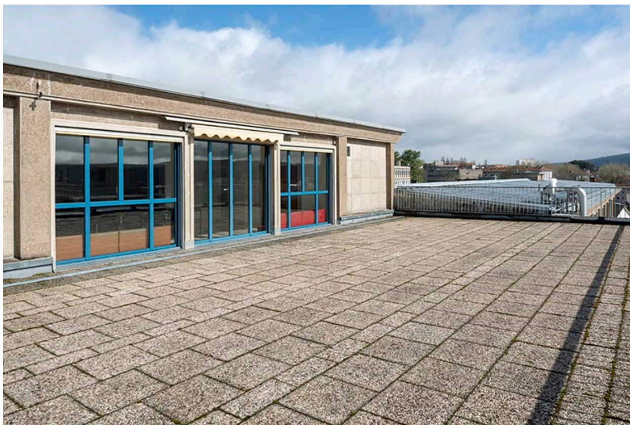
1er étage, corps central : terrasse et cantine.
