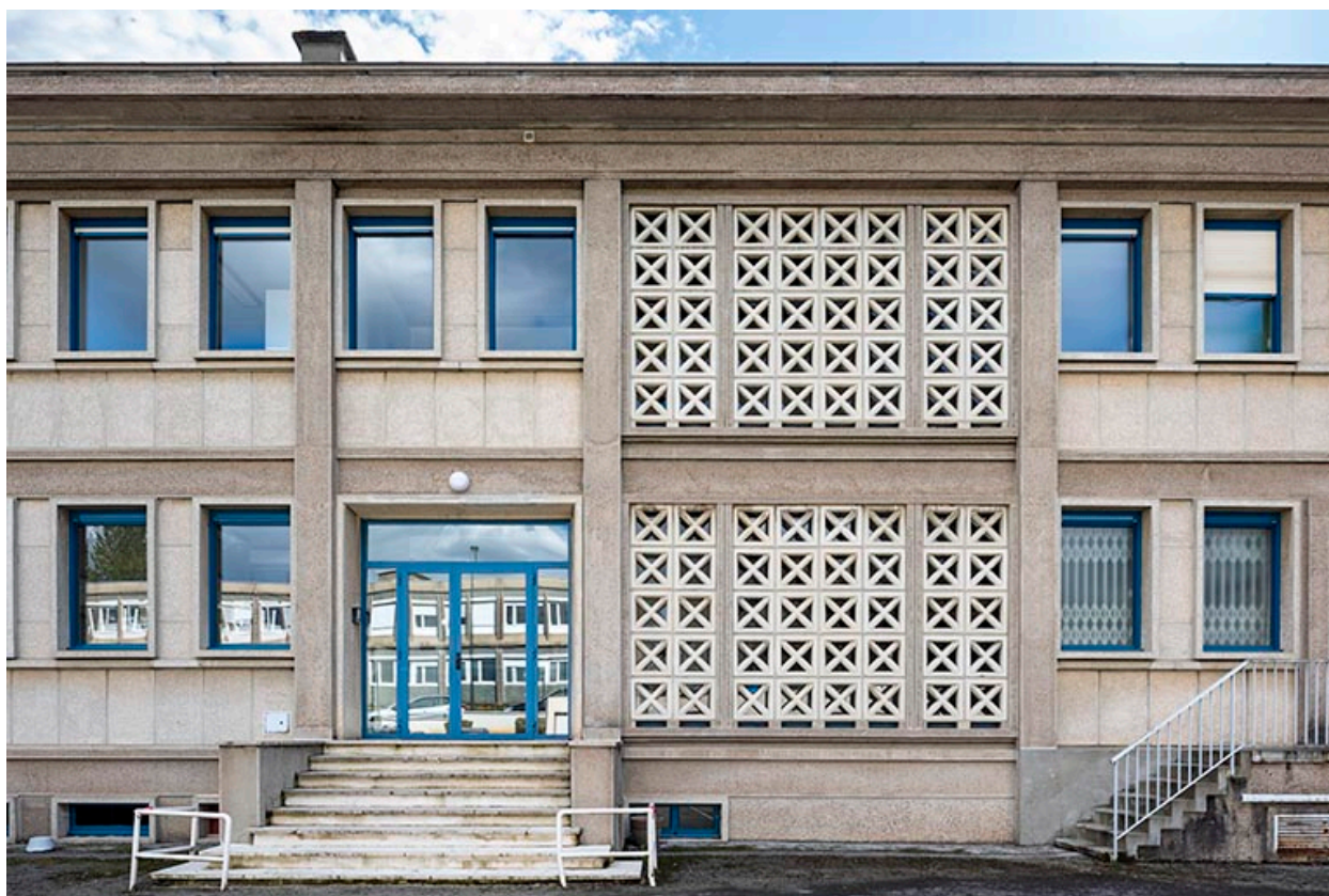
Façade antérieure, corps oriental : travées.
