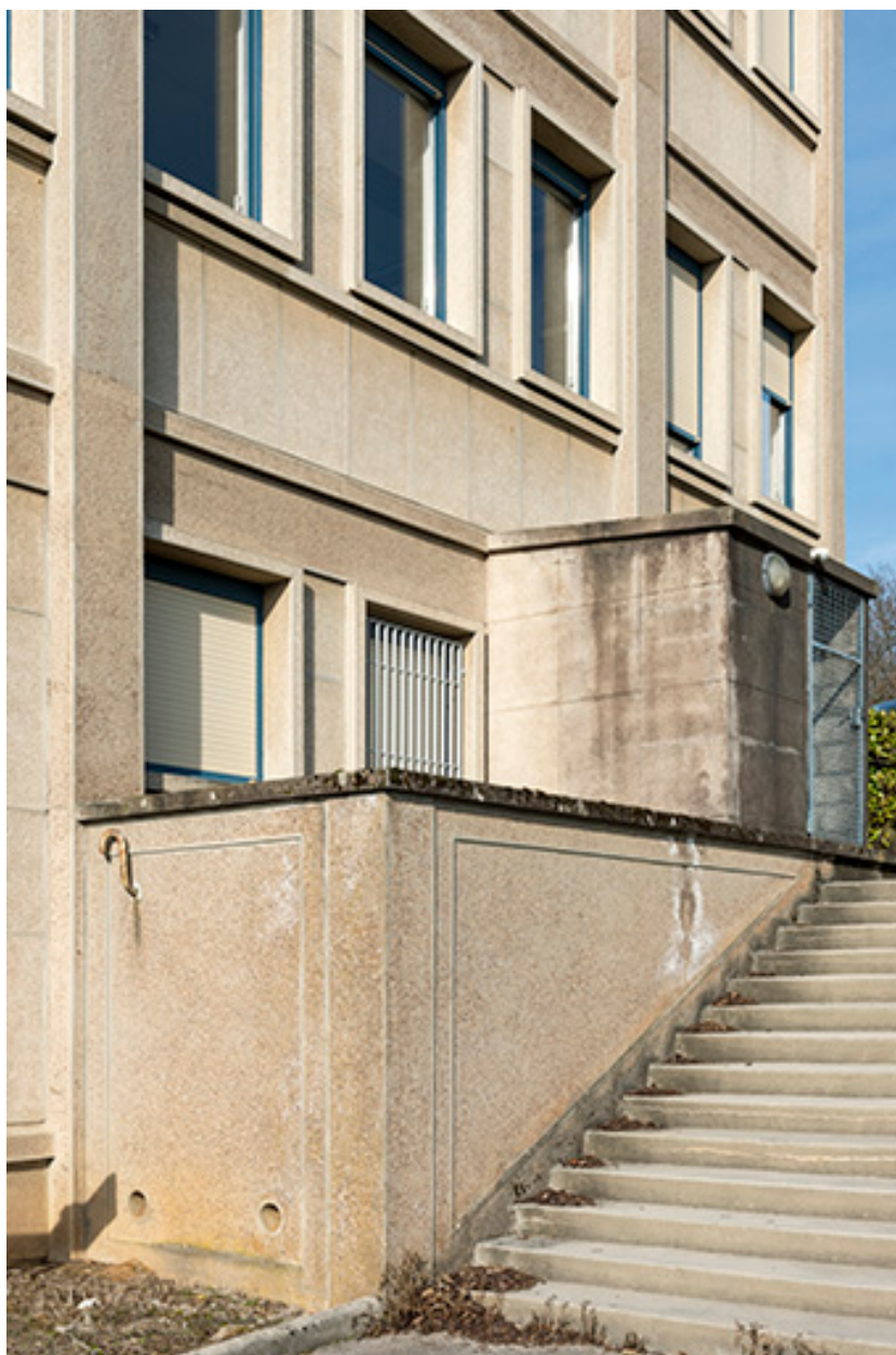
Façade latérale gauche (corps oriental) : escalier indépendant.
