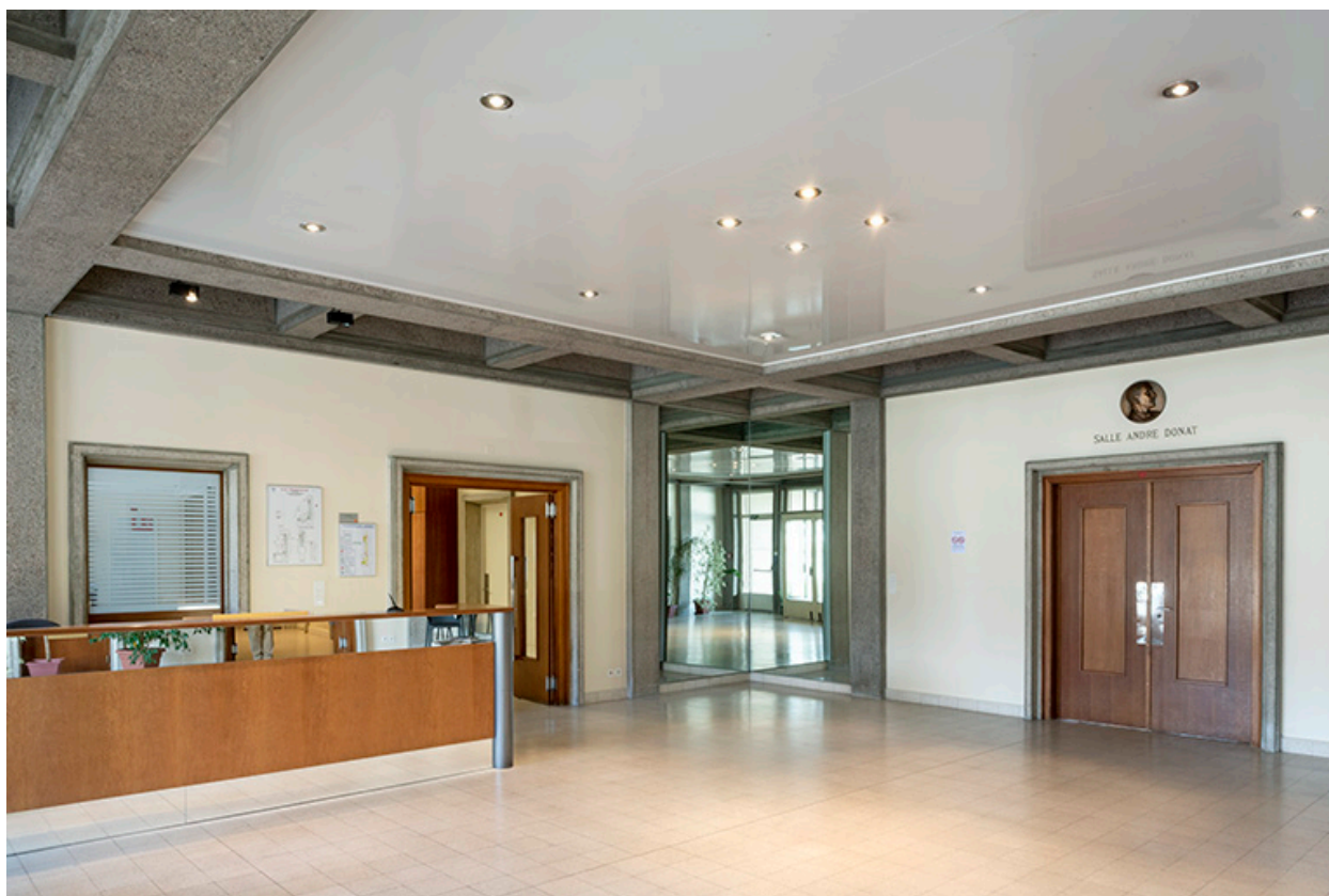
Rez-de-chaussée, corps central : hall d'entrée.
