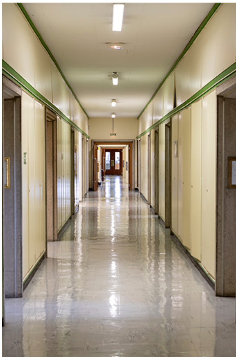
1er étage de soubassement : couloir.
