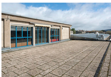
1er étage, corps central : terrasse et cantine.
