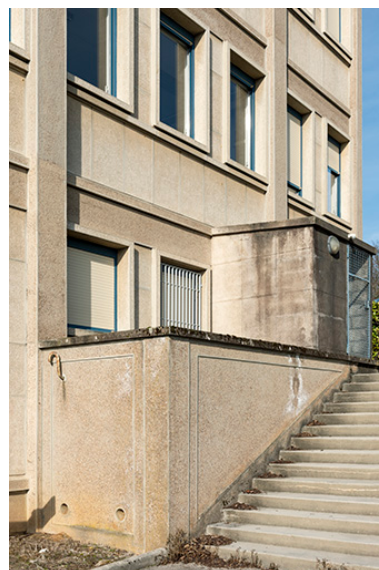
Façade latérale gauche (corps oriental) : escalier indépendant. Phot. Sonia Dourlot IVR43_20192500211NUC4A
