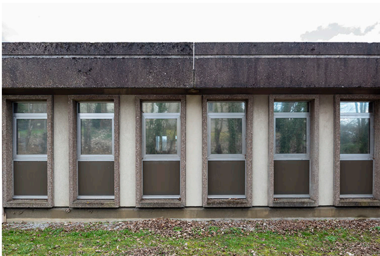
Ancien laboratoire de métrologie : fenêtres.
