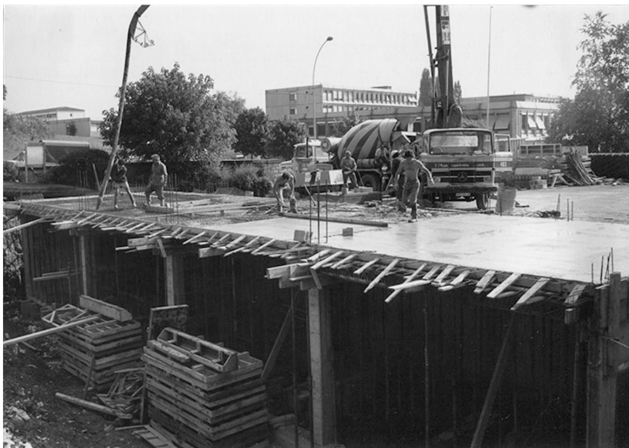
[Construction du laboratoire de métrologie, rez-de-chaussée : coulage du plancher en béton], 1981.
