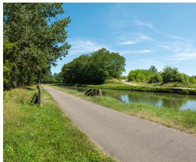
Vue de l'aqueduc. Phot. Pierre-Marie Barbe-Richaud IVR26_20177100245NUC2A
