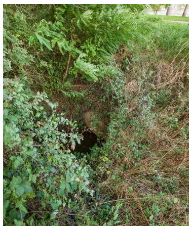
Vue de l'aqueduc.
