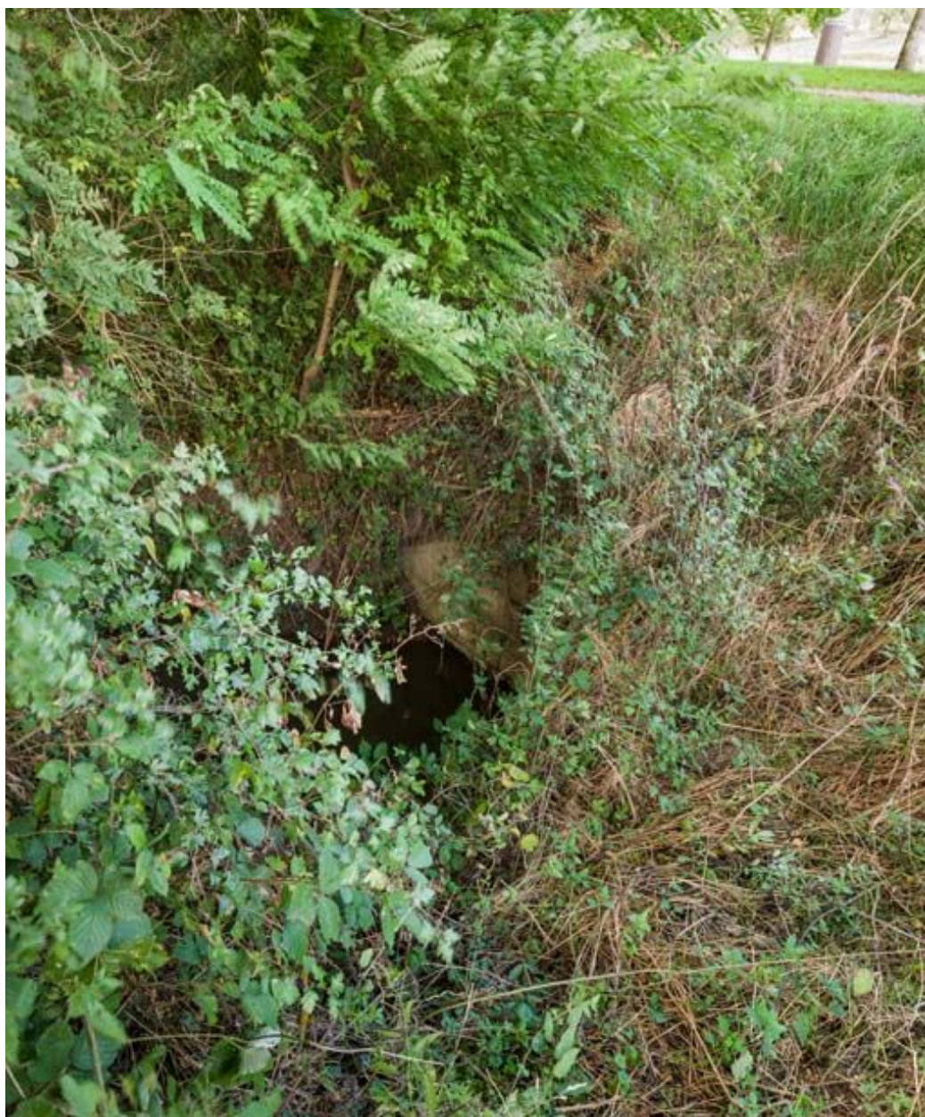
Vue de l'aqueduc.
