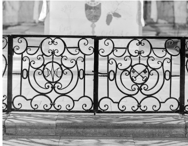
Détail : portillon. Phot. Yves Sancey IVR43_19837000083V
