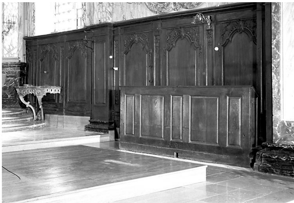
Vue d'ensemble des lambris du mur droit.
