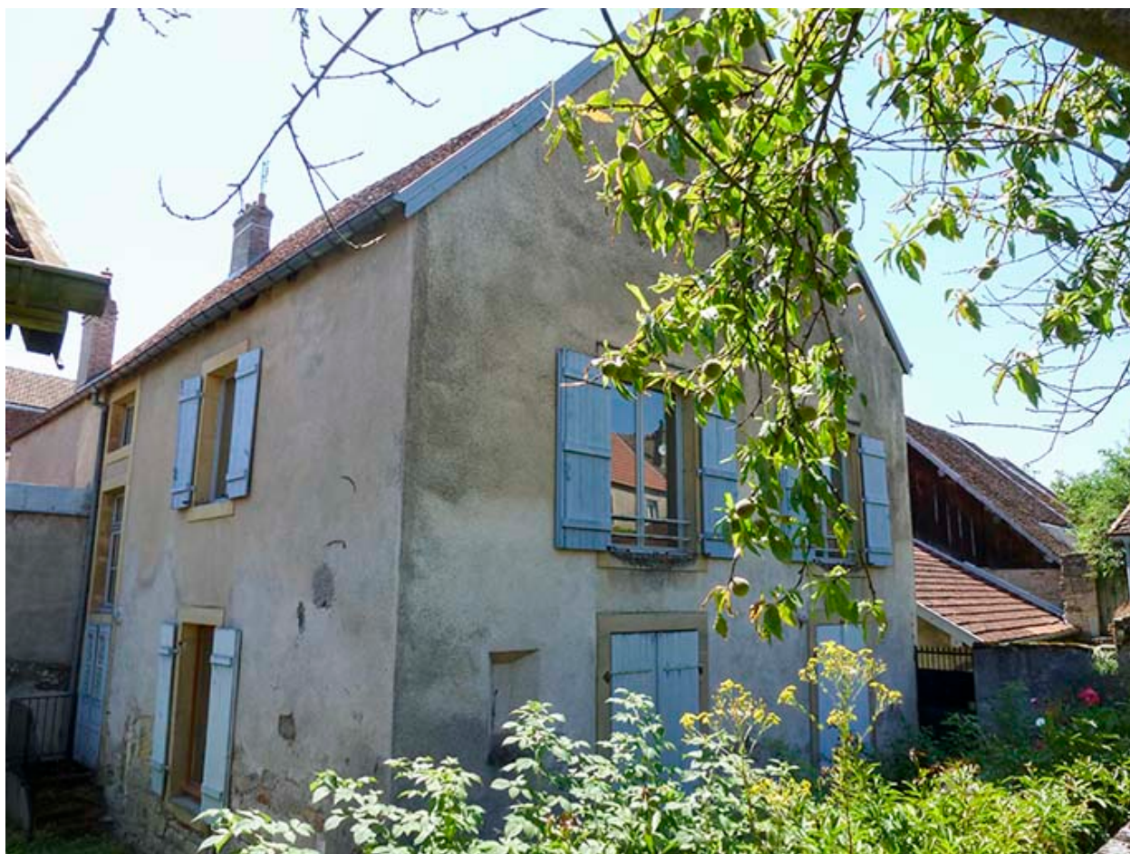
Façades postérieure et latérale droite.
