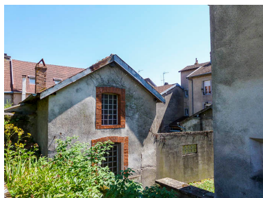
Vue générale de la remise.
