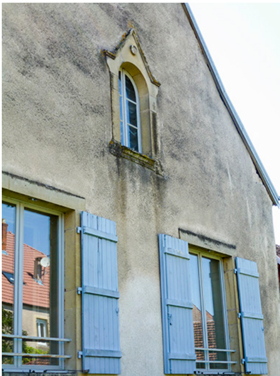
Façade postérieure : vue rapprochée.
