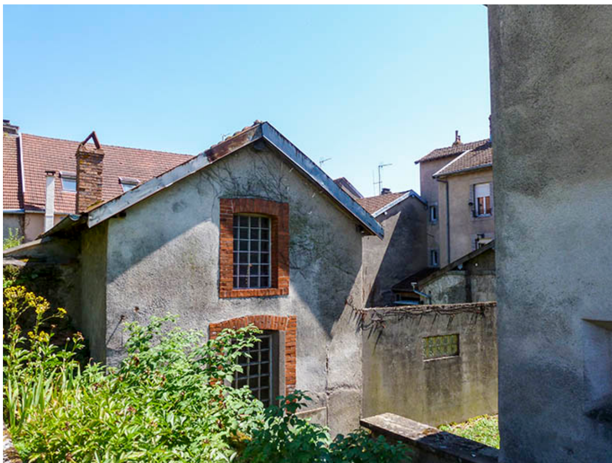
Vue générale de la remise.
