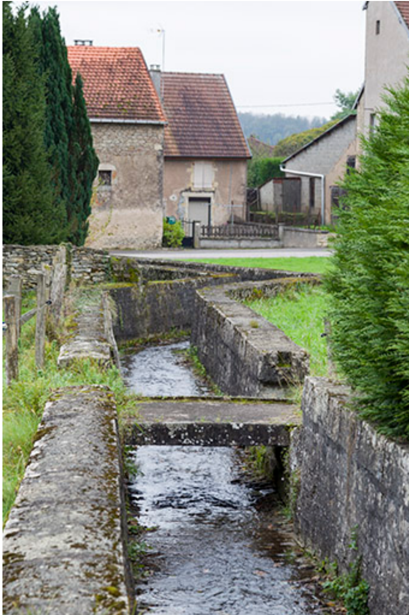
Le ruisseau canalisé traversant le village.
