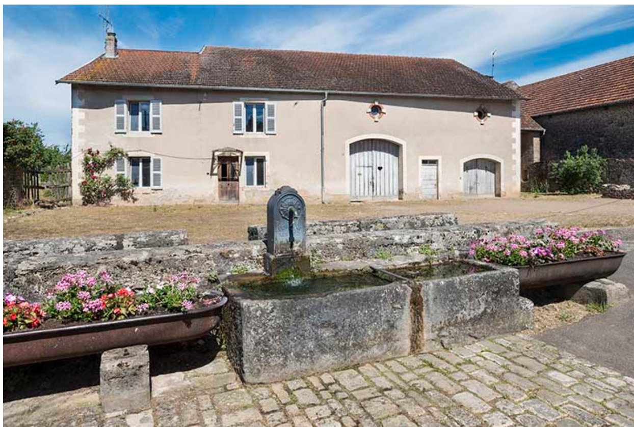
Ferme et borne-fontaine rue de la Prarie.
