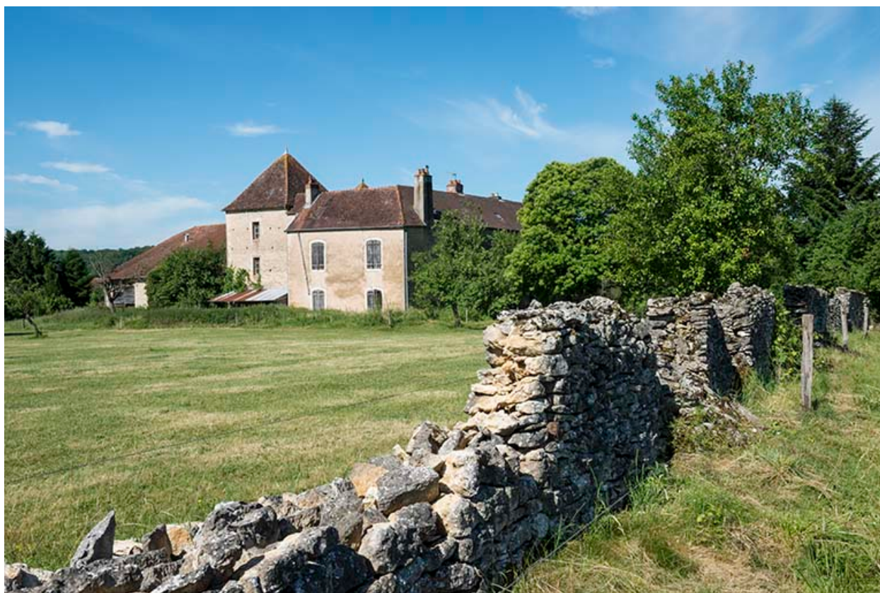
La façade orientale de la maison forte.
