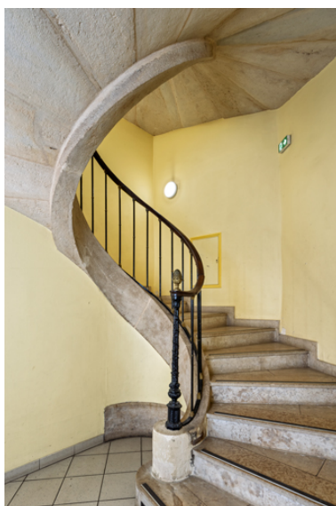
Rez-de-chaussée : escalier en vis. Phot. Pierre-Marie Barbe-Richaud IVR26_20245800355NUC4A
