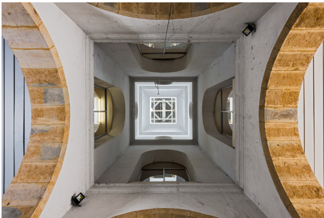
Rez-de-chaussée, halle : lanternon.
