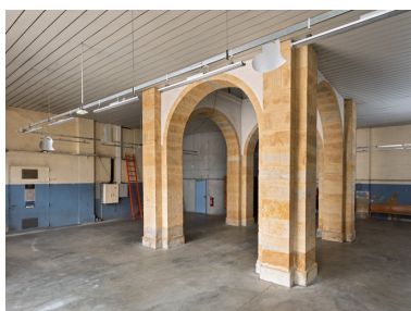
Rez-de-chaussée, halle : vue d'ensemble. Phot. Pierre-Marie Barbe-Richaud IVR26_20245800359NUC4A
