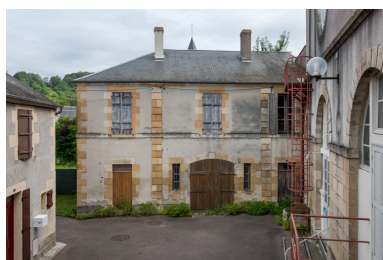
Ancienne remise. Phot. Pierre-Marie Barbe-Richaud IVR26_20245800344NUC4A
