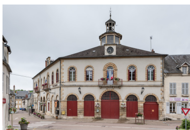
Façade latérale droite. Phot. Pierre-Marie Barbe-Richaud IVR26_20245800340NUC4A
