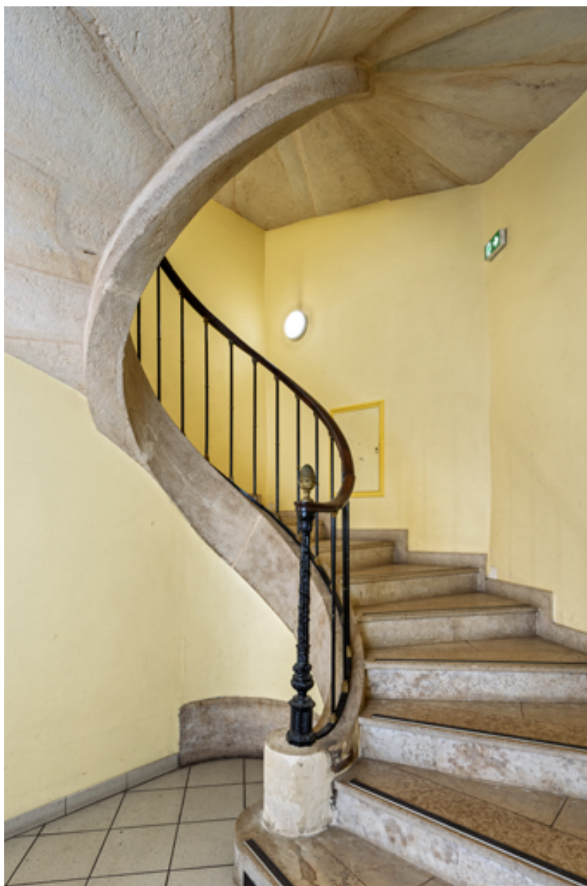
Rez-de-chaussée : escalier en vis.
