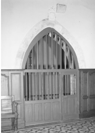
Vue générale Phot. Jean-Luc Duthu IVR26_19852101153V
