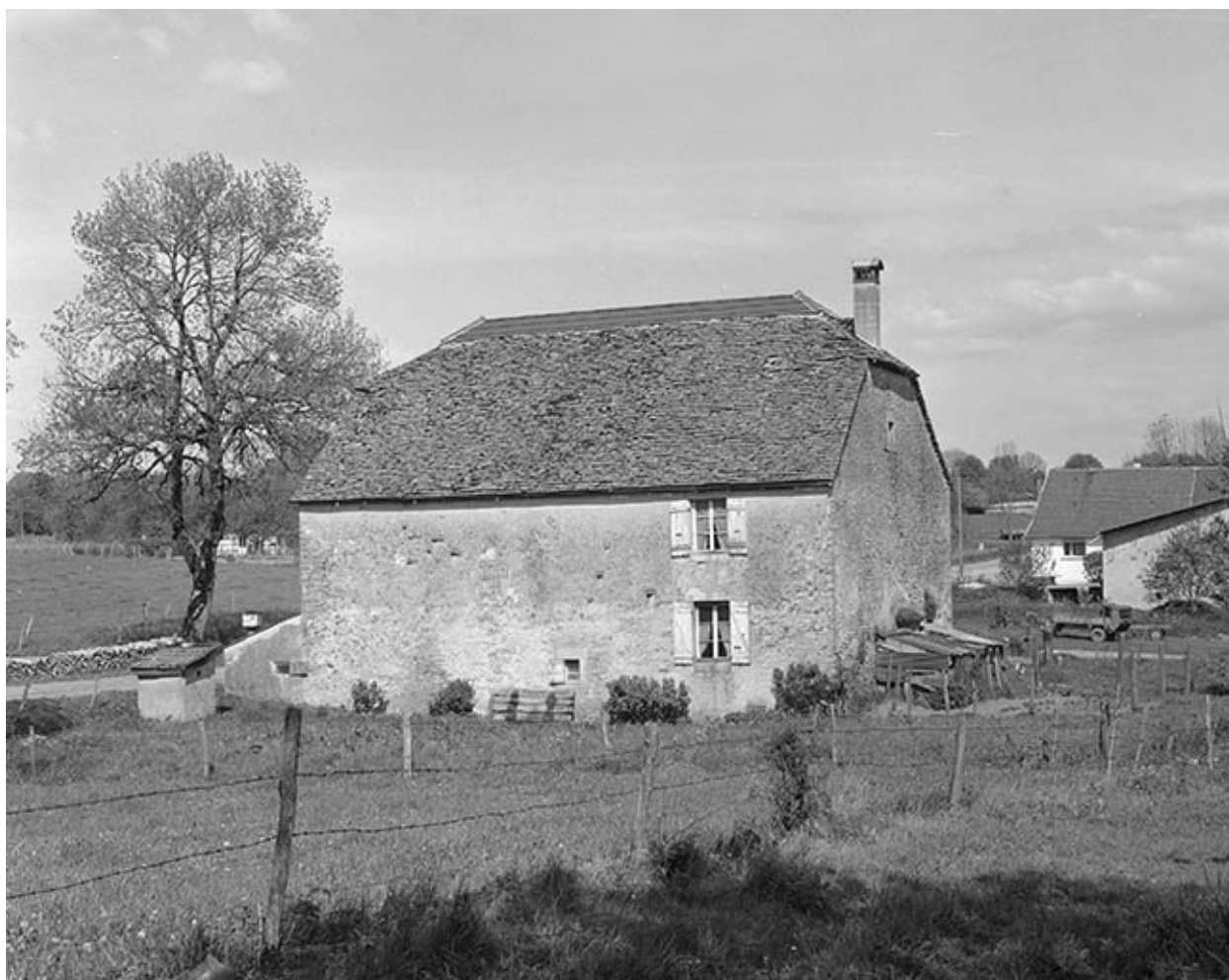
Ferme située à Granges de Ladoye : façades postérieure et latérale gauche.
