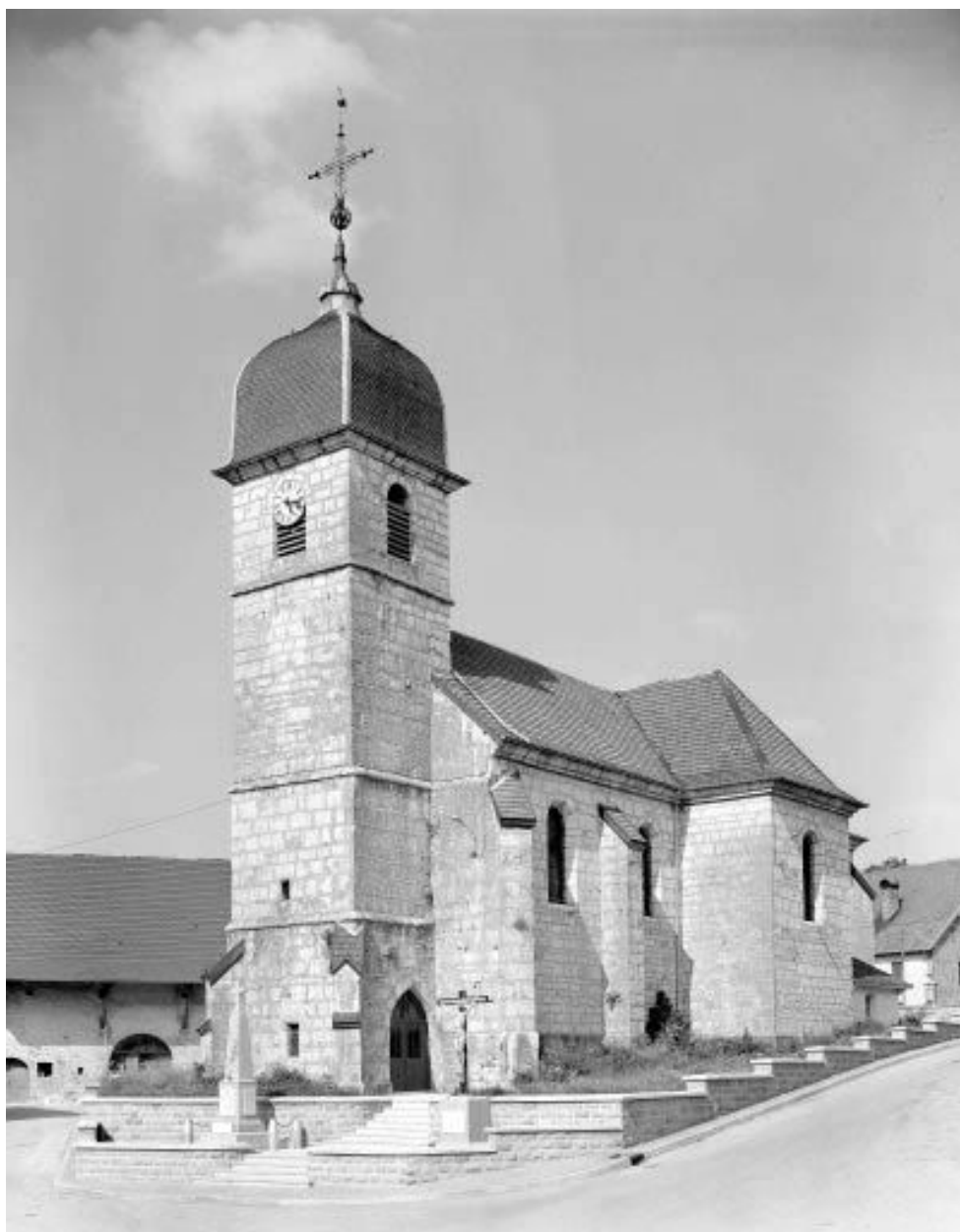
Facades antérieure et latérale droite.
